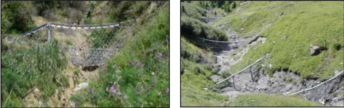
**Foto 14:** Diseño de barras flexibles de cables para retener corrientes de flujos de detritos.
