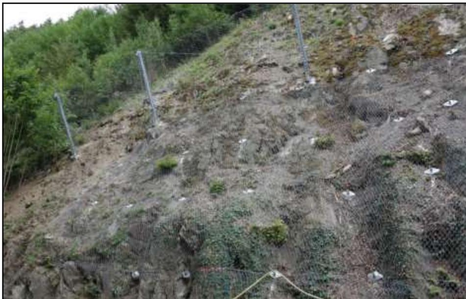
**Foto. 16** mallas de alambre metálico aplicado a talud inestable
