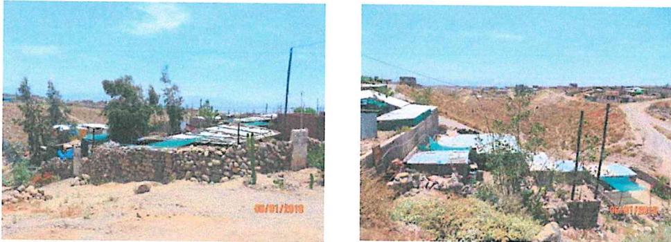
Ciudad de Dios, viviendas ubicadas en margen derecha de ribera de quebradas, Zona 3 Sector B.
