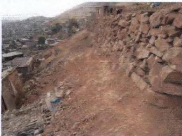
En las fotos 11 y 12, se observan pircas sin ningún tipo de amalgamación, hasta de 2 m altura e incluso una de material noble; en la foto 13, se observa igualmente pirca sin adhesión al borde del talud del lote inferior y fuerte pendiente
