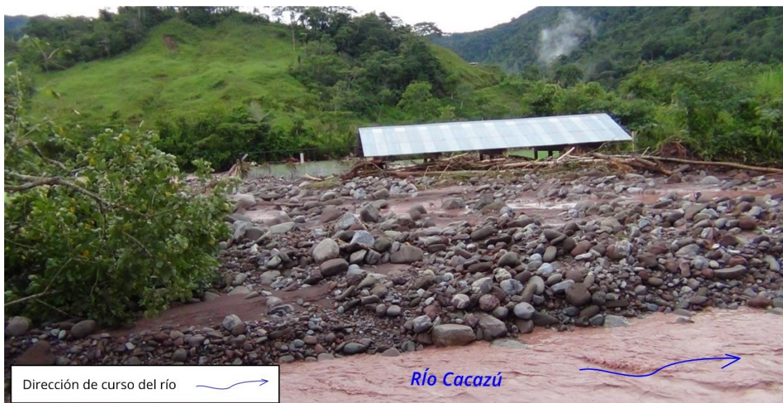
Figura 12. Planta de tratamiento destruida por crecida del río Cacazú. Foto INDECI - Villa Rica.
