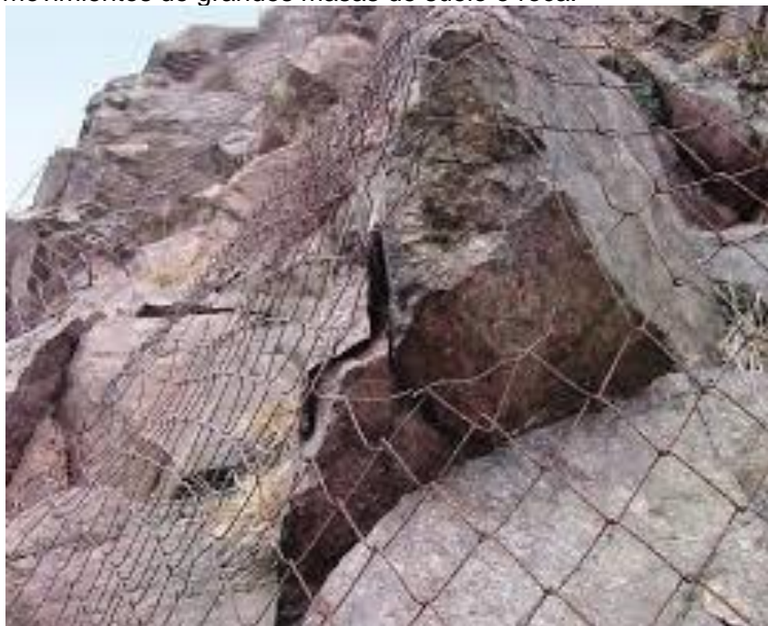
Figura 24. Control de caída de rocas utilizando mallas ancladas
