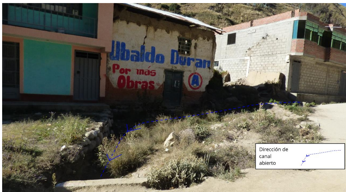
Figura 23. Canales revestidos por tramos en calle de Quiparacra.
