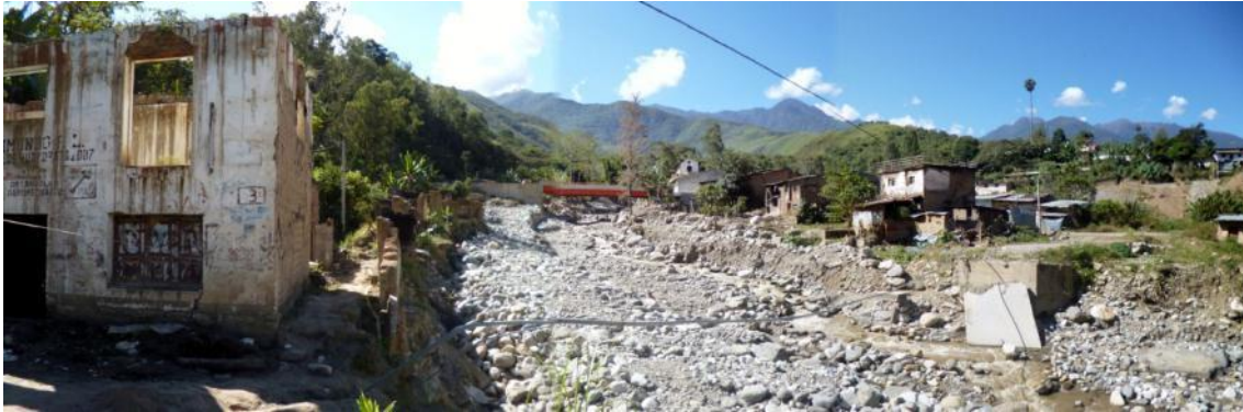
Foto 5: Daños en viviendas ubicadas cerca del cauce de la quebrada Calquiña (Foto Vilchez 2013).
