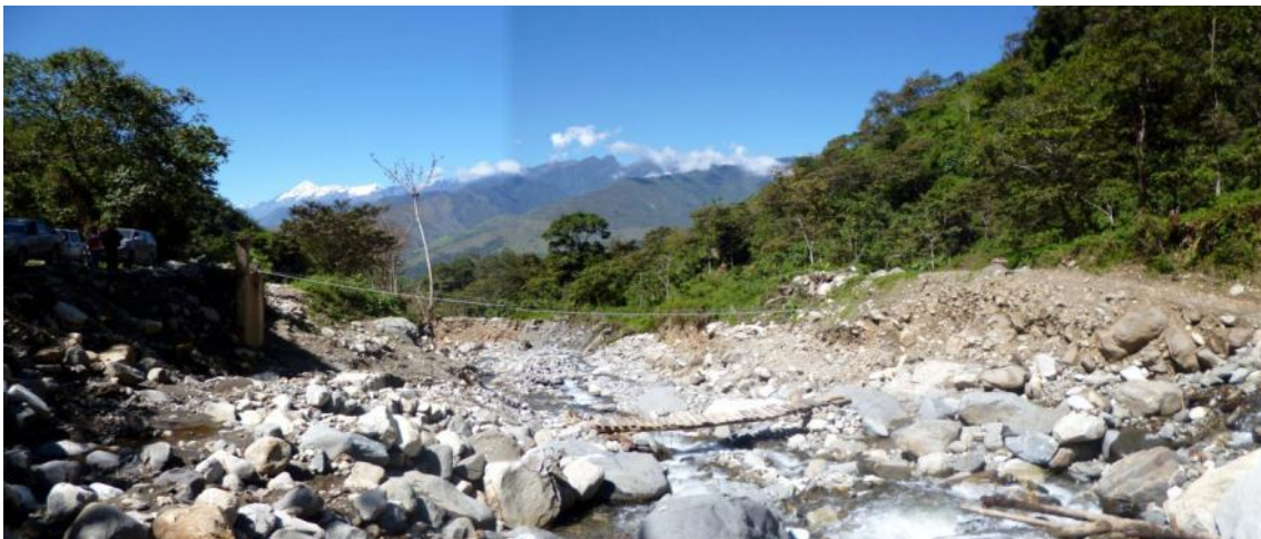
Foto 4: Ancho del cauce de la quebrada Calquiña de 30 m, donde se puede observar el material gravoso, los bolos y bloques que han quedado en el cauce. En este punto el huaico destruyó un puente peatonal (Foto Vilchez 2013).
