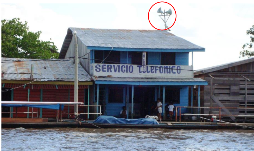
Fotografía 4. Viviendas de Islandia, afectadas por inundación. Foto tomada en mayo 2009 por Marcos Chucas.
