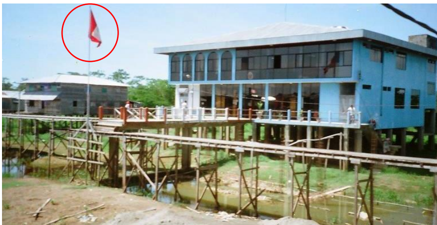
Fotografía 3. Local Municipal de Yavarí (Islandia), se observa la construcción de vías de acceso en base a concreto y madera. Foto tomada en octubre 2009.
