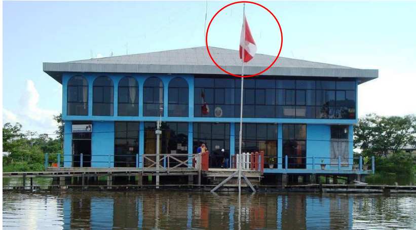
Fotografía 2. Local Municipal de Yavarí (Islandia), afectado por la inundación. Foto tomada en mayo 2009 por Marcos Chucas.
