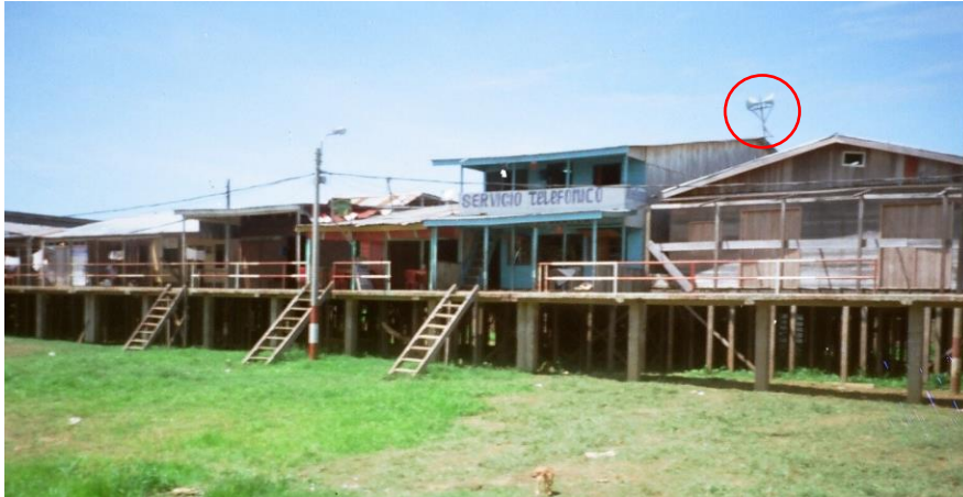
Fotografía 5. Viviendas de Islandia, construidas sobre columnas de 2 m altura. Foto tomada en octubre 2009.
