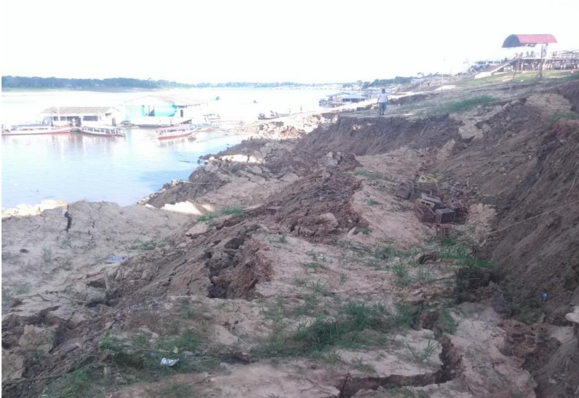
Fotografía 9. Vista tomada el 12 de agosto del 2018 de la escapa de deslizamiento retrogresivo producto de los procesos de la erosión fluvial en la calle 02 de Julio. Localidad de Islandia. Foto: Municipalidad distrital de Yavarí.
