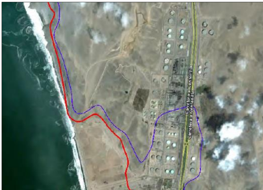
Figura N° 22: Inundación en La Pampilla
