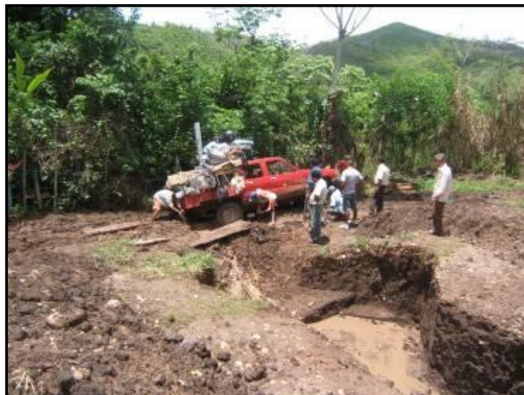
Foto 23.- Erosión en cárcavas, que afecta carretera Pachiza-San Ramón.
