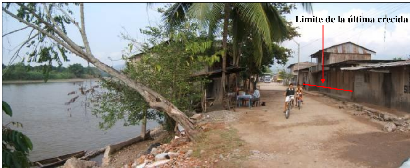
Foto 21- Puerto de Juanjui, zona sujeta a inundaciones en tiempos de crecida excepcional, nótese el nivel de las aguas que llegaron en enero del 2007.
