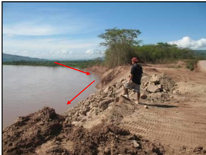
Foto 29.- Sector de Pucacaca, margen izquierda del río Huallaga, carretera Tarapoto-Picota Km. 45+300, nótese que el río esta erosionando este sector, muy cerca se encuentra el tramo de carretera.
