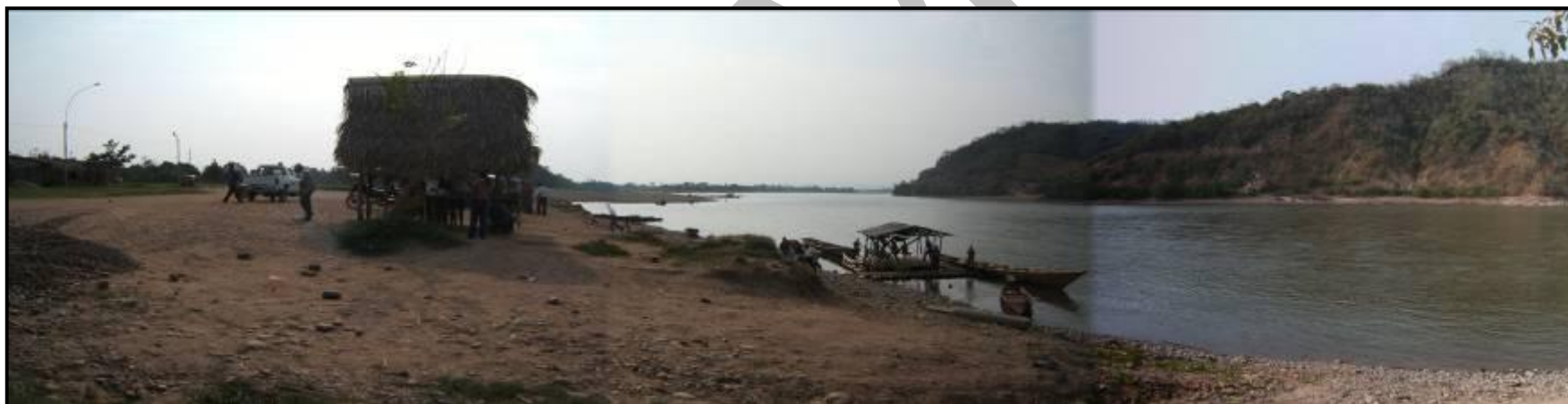
Foto 31.- Puerto de Bellavista, ubicado en la margen derecha del río Huallaga.
