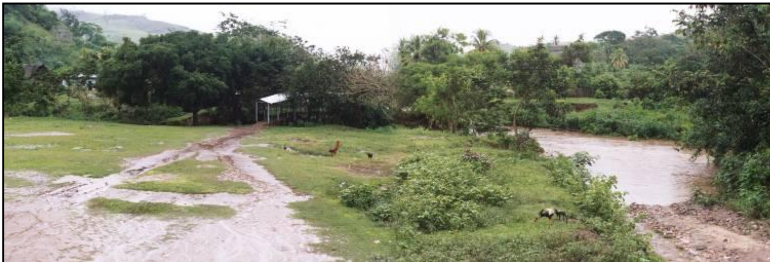
Foto 9.- Sector de Las Flores de Mamonauhua, área sujeta a inundaciones.
