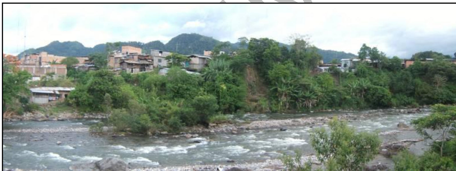
Foto 12.- Erosión fluvial e inundación en el sector de Naranjos (Pardo Miguel).
