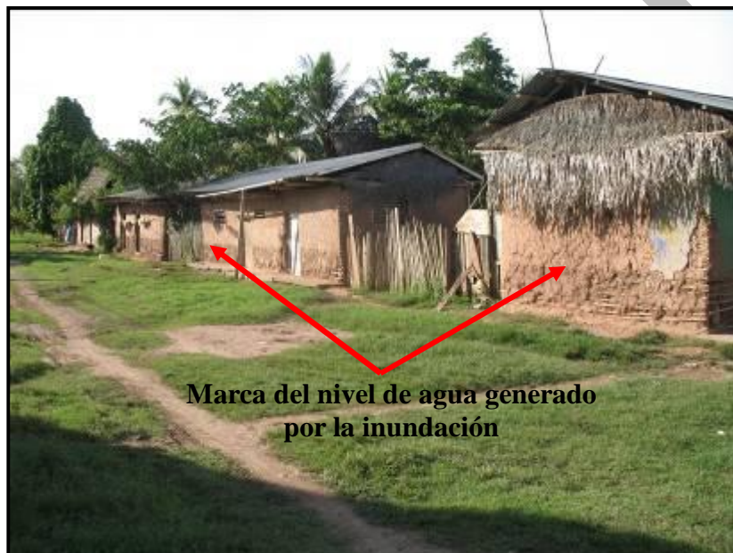
Foto 24.- Inundación de Santa Elena, en las paredes de las viviendas se notan las marcas hasta donde llegó el nivel de las aguas del río Biavo, (inundación Marzo 2007).
