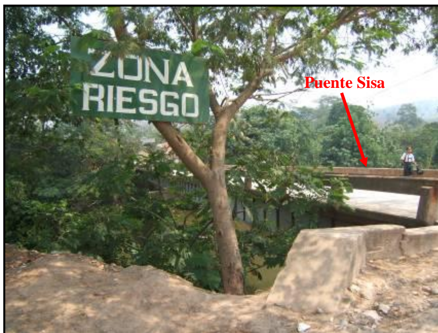
Foto 19.- Sector de Sisa, El Dorado, margen izquierda del río Sisa, en tiempos de crecida excepcionales el río desborda en este sector, y llega casi a cubrir al puente.
