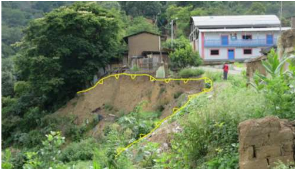
Foto 04: Deslizamiento rotacional en la zona urbana del caserío La Esperanza
