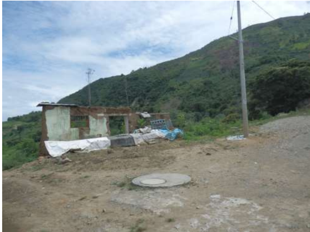
Foto 08: Vivienda destruida y poste de alumbrado público que puede ser afectado por el deslizamiento
