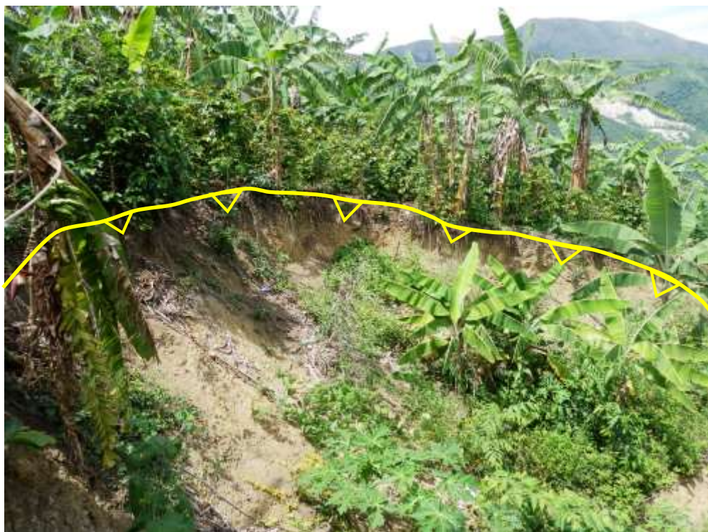
Foto 06: Deslizamiento con escarpe de 16 m y salto de 5 m que afectó áreas de cultivo
