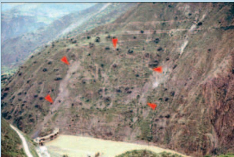
Foto 3. Embalse Tablachaca: Derrumbe 5 (febrero de 1982)
