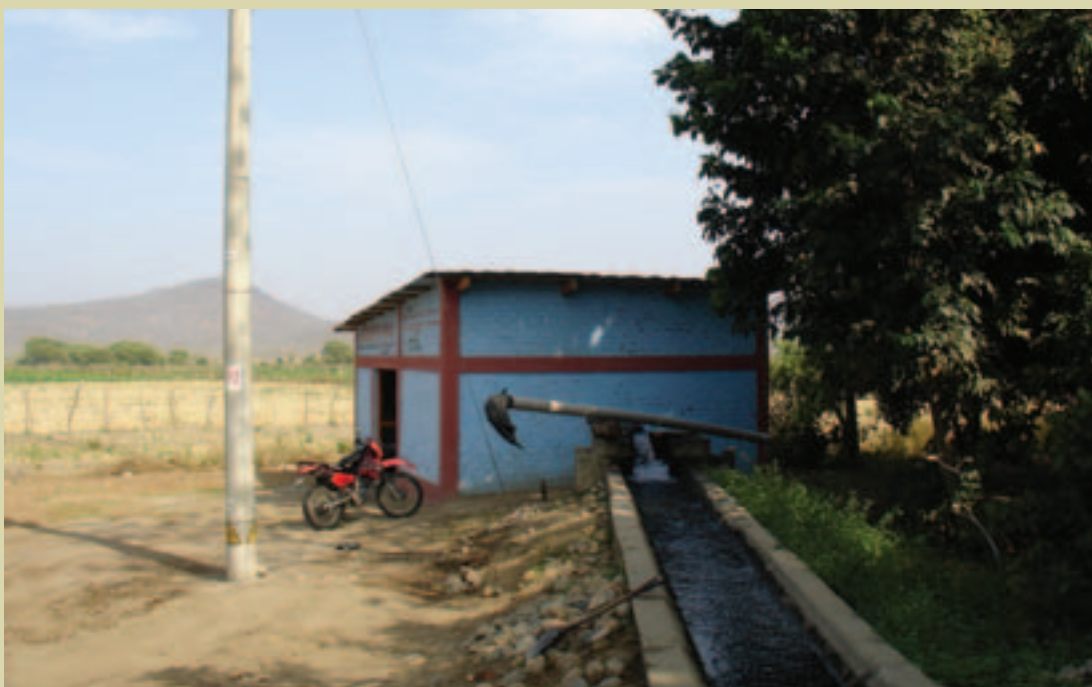
Foto 1. Pozo Nuñez – Morropón, Piura. Rehabilitación de pozos de agua en áreas de sequía.
