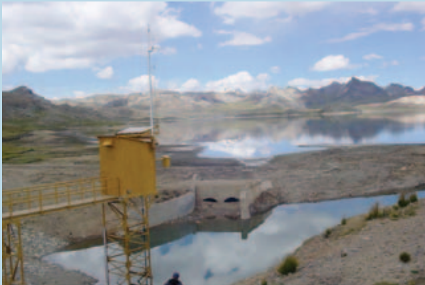
Foto 5. Cuenca del río Mantaro: estación de medición y control en laguna regulada
