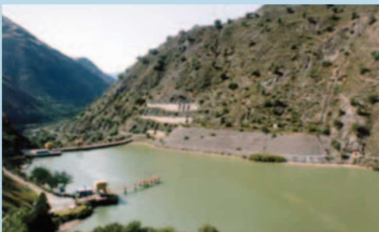
Foto 4. Embalse Tablachaca: contrafuerte enrocado del Derrumbe 5 (febrero de 1982)
