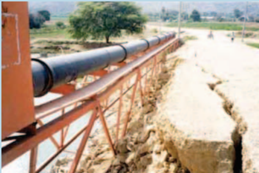
Foto 6. Eje Paita-Talara: tubería de conducción
