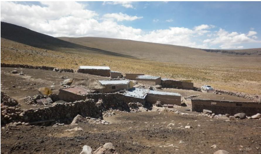
Foto 5: VIVIENDA ZONA RURAL YANAHUARA
