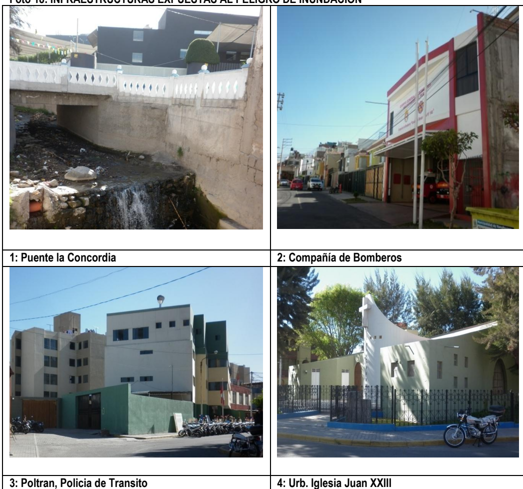
Foto 18: INFRAESTRUCTURAS EXPUESTAS AL PELIGRO DE INUNDACIÓN
