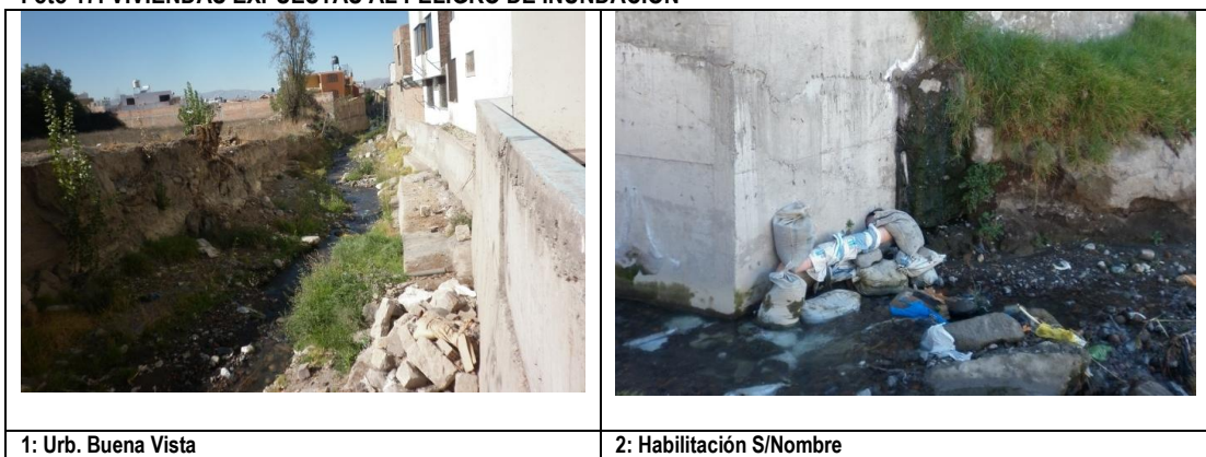
Foto 17: VIVIENDAS EXPUESTAS AL PELIGRO DE INUNDACIÓN
