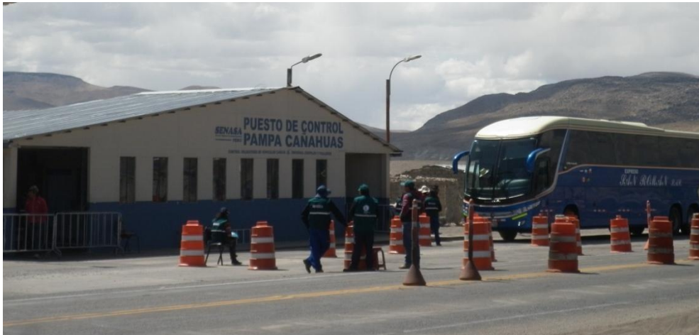
Foto 7: EQUIPAMIENTO CENTRO POBLADO DE PATAHUASI
