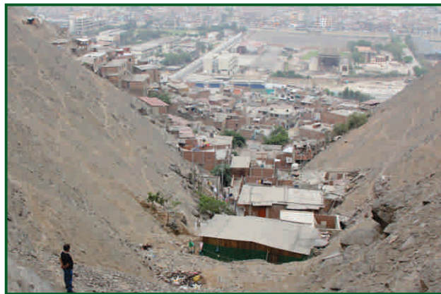
Viviendas asentadas en pleno cauce de una quebrada, que se encuentran expuestas a flujos de agua y escombros
