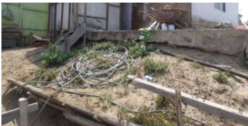
Foto 12: Vista de terraplén construido sobre las arenas eólicas.
