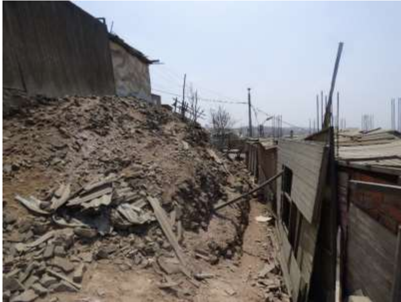
Foto 14: Se observa viviendas ubicadas en zonas susceptibles.
