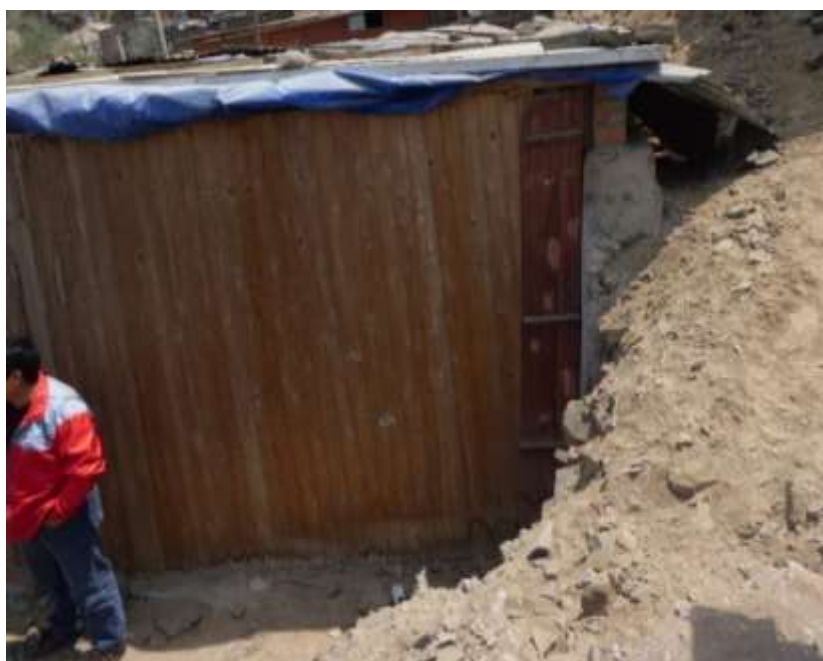
Foto 13: Cortes de talud para la construcción de viviendas.
