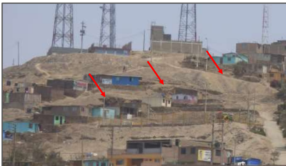
Foto 11: Corte de talud sobre depósitos eólicos para la construcción de viviendas y vías de acceso (señalados con flechas rojas), que están colapsando.
