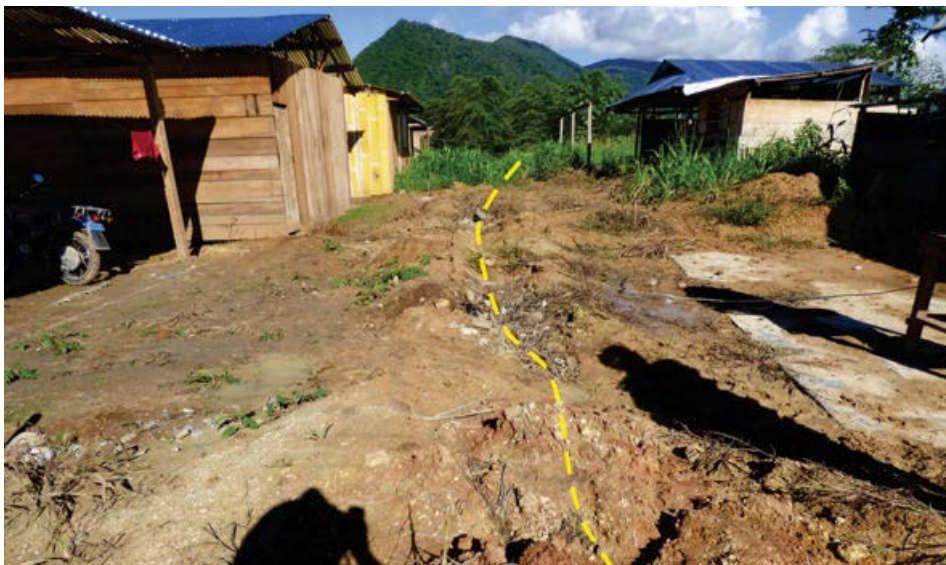
Foto 10. Zona donde se excavó para la instalación de la red de desagüe local.
