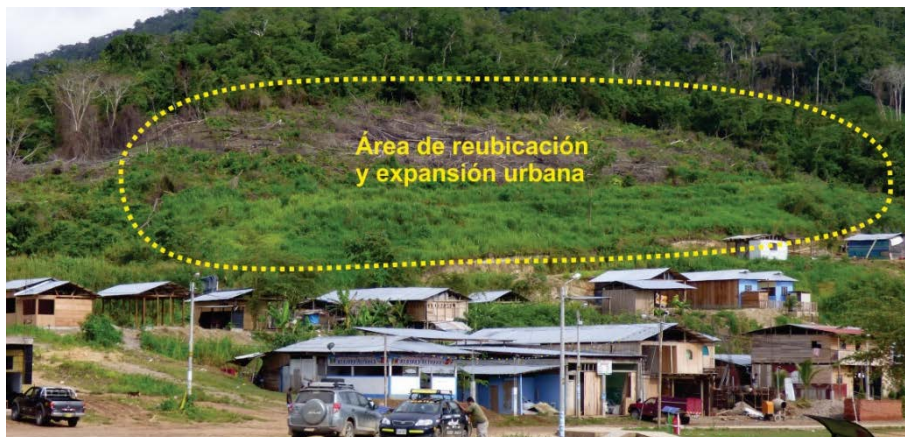
Foto 13. Ubicación de la zona de reubicación
