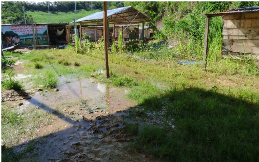
Foto 11. Se aprecia el charco formado por la falta de un drenaje pluvial.
