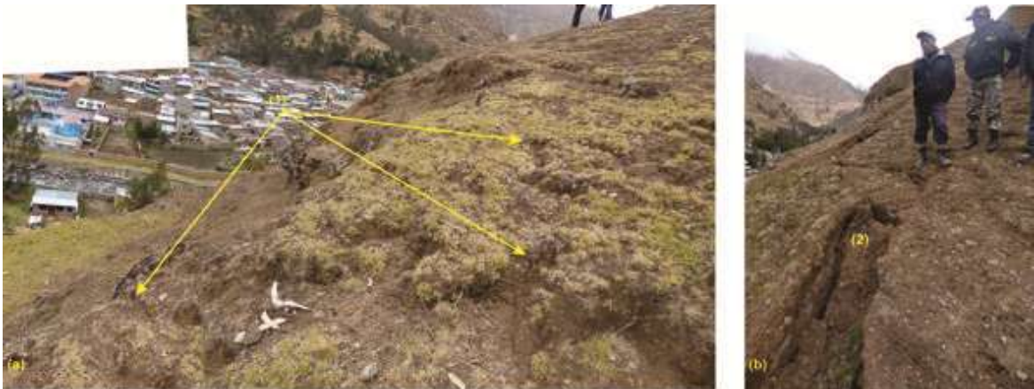
Fotos 7a y 7b. El agrietamiento del terreno se aprecia en forma milimétrica, en la foto 7b se observa una apertura hasta de 30 cm.
