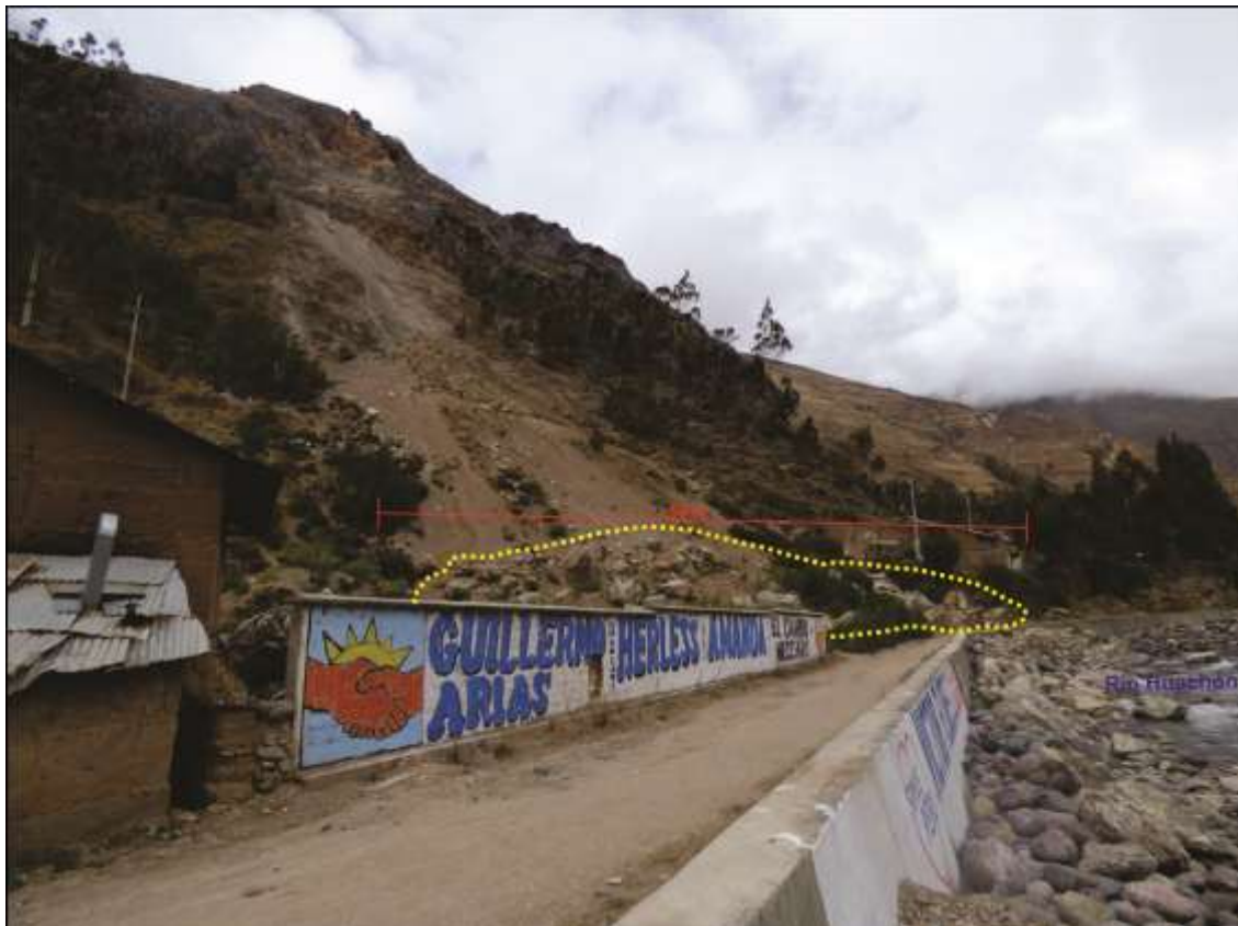
Foto 3. Se muestra las escarpas de los derrumbes y el material desplazado.
