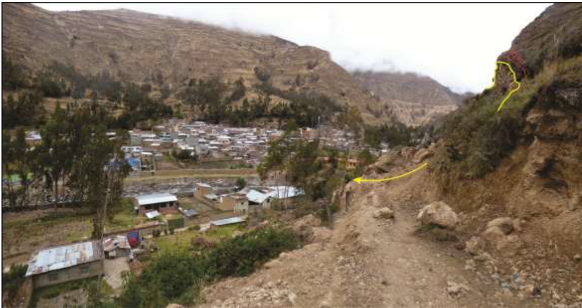
Foto 5. Derrumbe ocurrido en el 2014.
