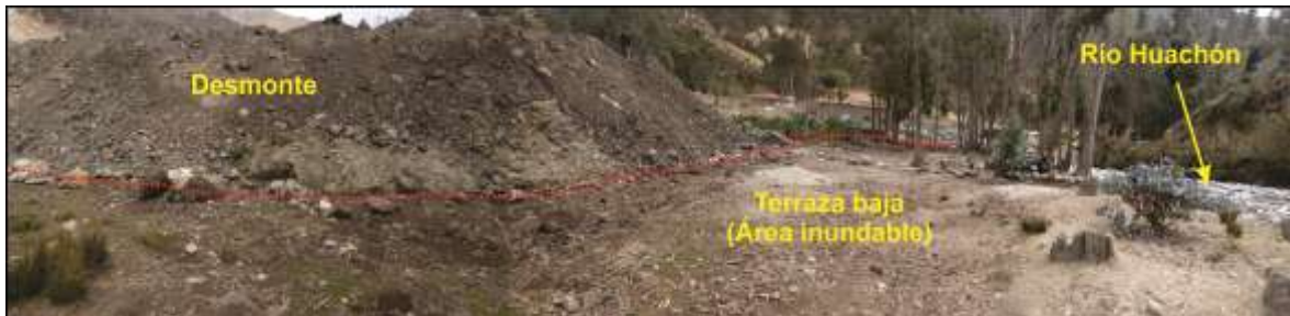
Foto 12. Se aprecia la terraza baja cubierta por desmonte, y la cercanía al río Huachón.
