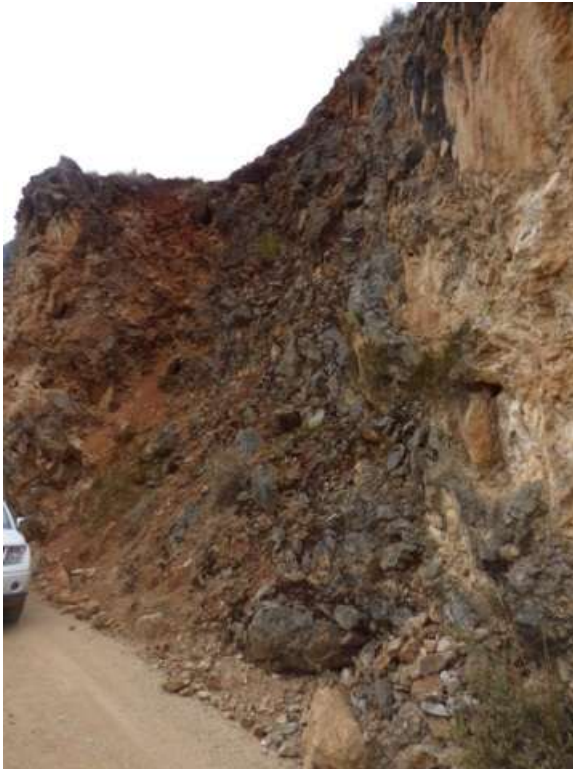
Foto 1. Brecha de falla, se muestra el material rocoso triturado
