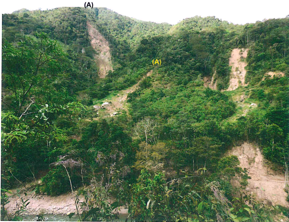
Foto 14. Margen derecha del río Tulumayo, se aprecian cicatrices de las zonas de arranque de avalancha de detritos (A).
