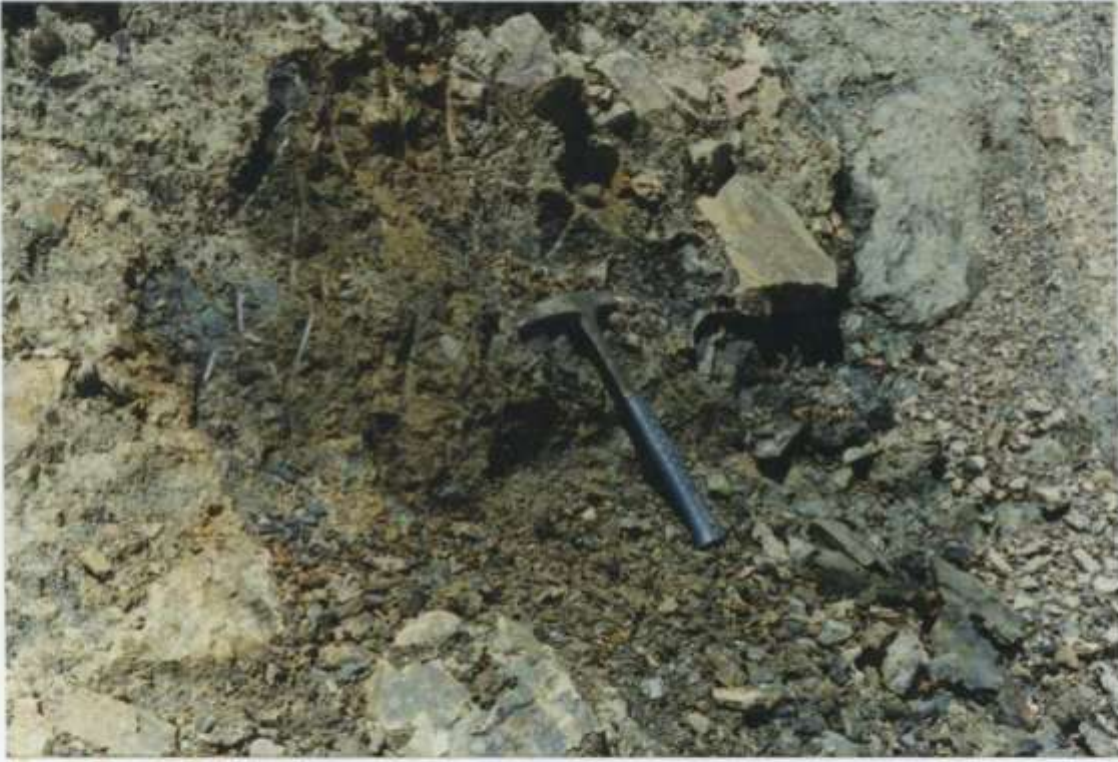
Foto 7: Filtraciones en rocas muy fracturadas y meteorizadas (lutitas carbonosas).
