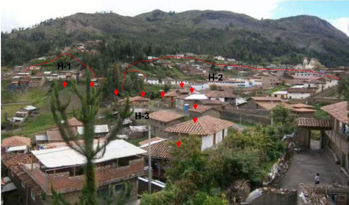
Foto 16: Se observan los deslizamientos H-1, H-2 y H-3, los cuales viene afectando viviendas, presentando agrietamientos y hundimientos.
