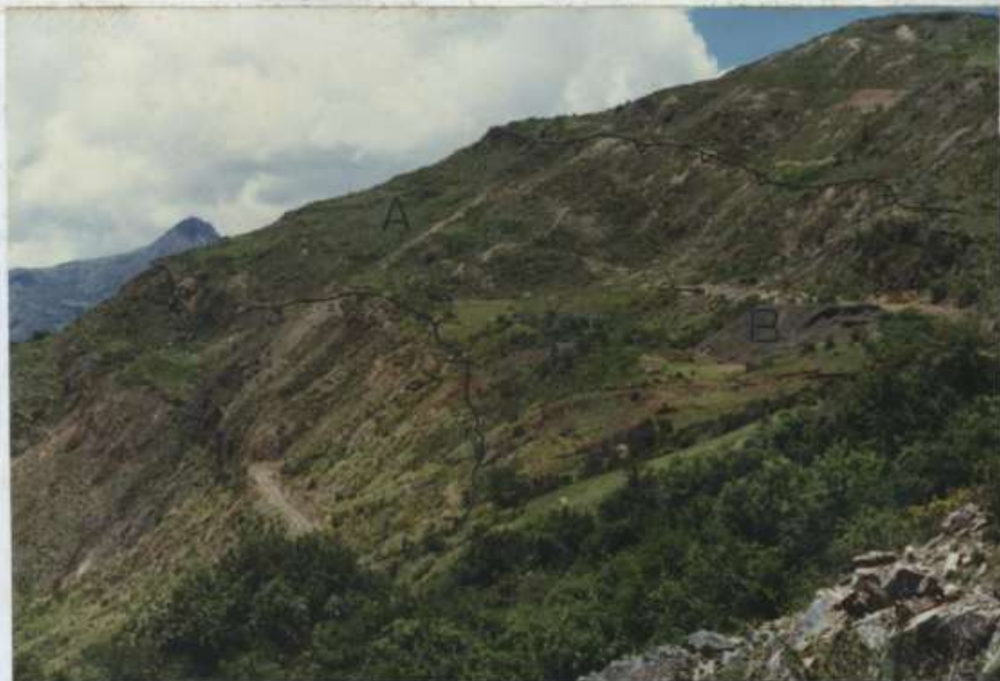
Foto 2: Escalonamientos en la parte Este del deslizamiento de San Luis (A) y canchas de labores antiguas (B).
