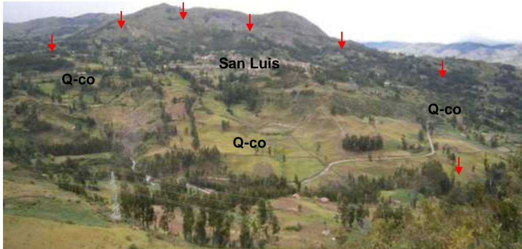
Foto 04: Se observa los depósitos del deslizamiento antiguo (Depósitos coluviales Q-co), sobre el cual se emplazó el poblado de San Luis, las flechas rojas delimitan dicho deslizamiento.
