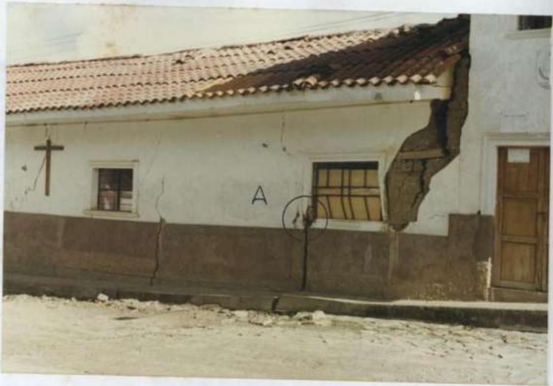
Foto 8: Fuertes agrietamientos en el local Parroquial (Plaza de Armas). A: Detalle en Foto 9.
