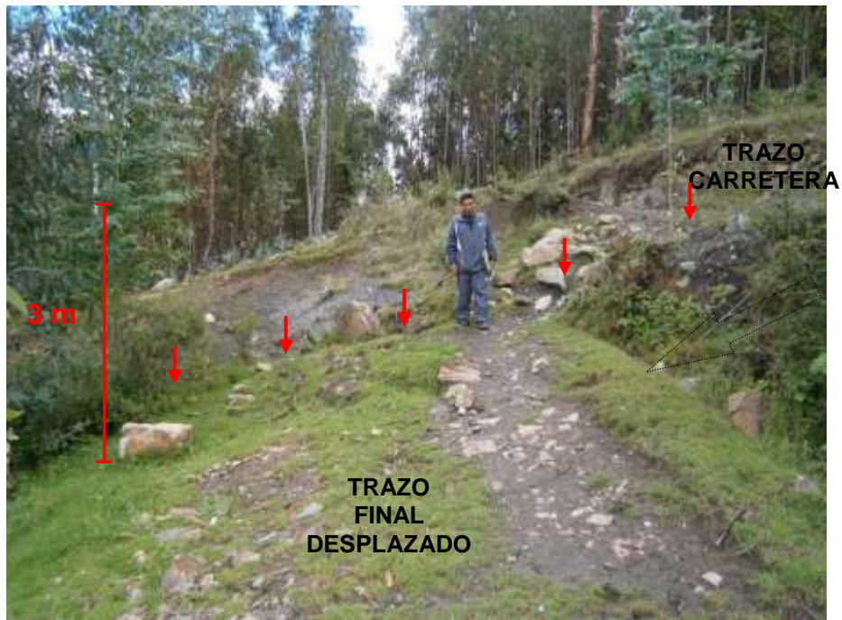
Foto 10: En la foto se observa el trazo de la carretera y el trazo final de la carretera desplazada 9.10 m, generando un desnivel de 3 m, las flechas rojas demarcan el flanco derecho del deslizamiento flujo C-2.
