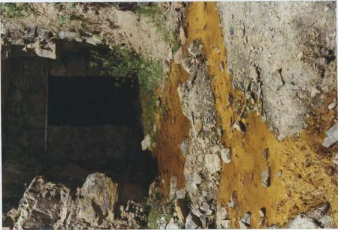
Foto 6: Agua ácida descargando hacia el cuerpo del deslizamiento, desde la bocamina "Polvorín"
