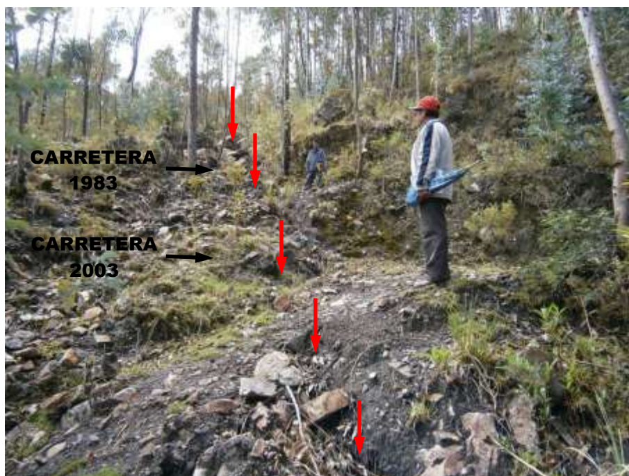
Foto 11: Las flechas rojas demarcan el flanco izquierdo del deslizamiento C-2, se observa los antiguos trazos de las carreteras de 1983 y 2003 que en la actualidad presenta un desnivel de 14.30 m con relación a la carretera de 1983.
