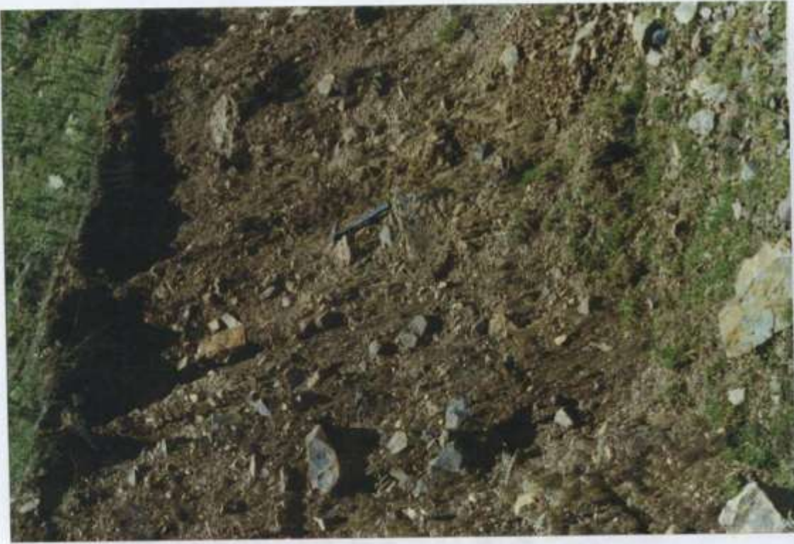
Foto 4: Talud de corte de la trocha carrozable hacia la Mina La Perla. Obsérvese los materiales que constituyen el depósito coluvio-proluvial.
