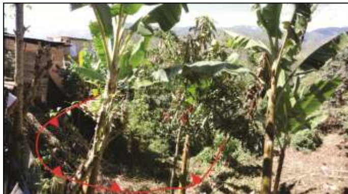
Foto 68. Se muestra un sector afectado por la reactivación
