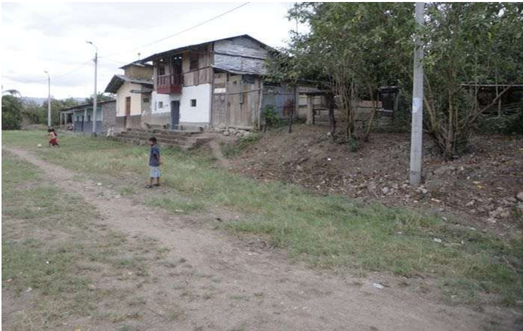
Foto 48. Viviendas afectadas por la última reactivación del deslizamiento.
