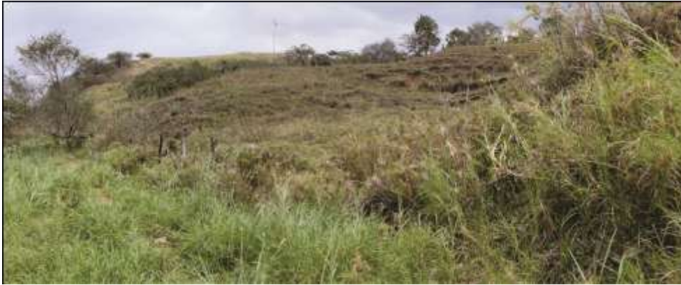
Foto 58. Se muestra la inestabilidad del terreno, con reptaciones de suelos.
