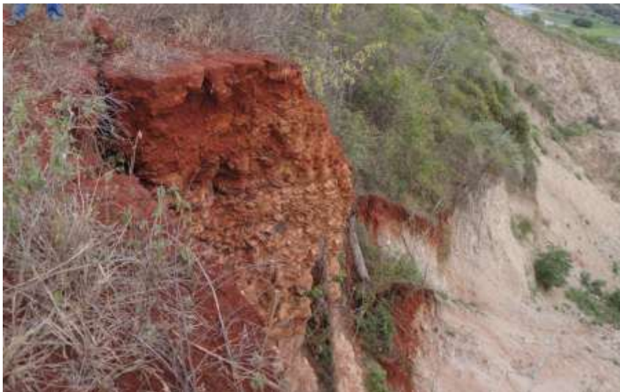
Foto 19. Deslizamiento 1, sector de Cunía, muestra una escarpa casi vertical
