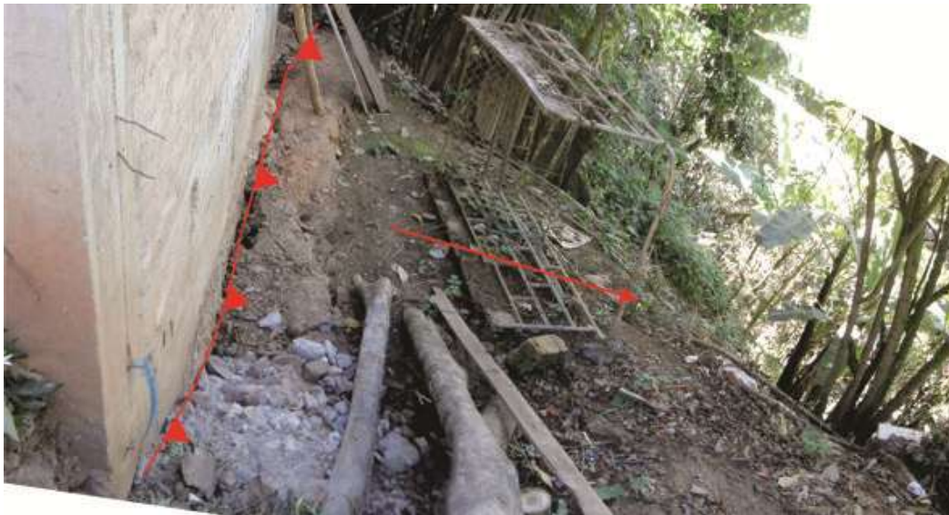
Foto 69. Zona inestable, la cual puede colapsar.
