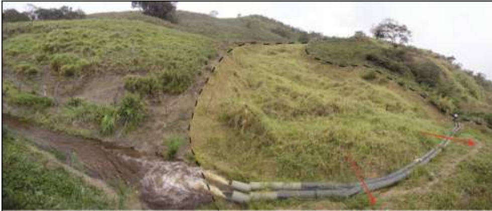
Foto 53. Deslizamiento-flujo, afectó a canal de regadío.
