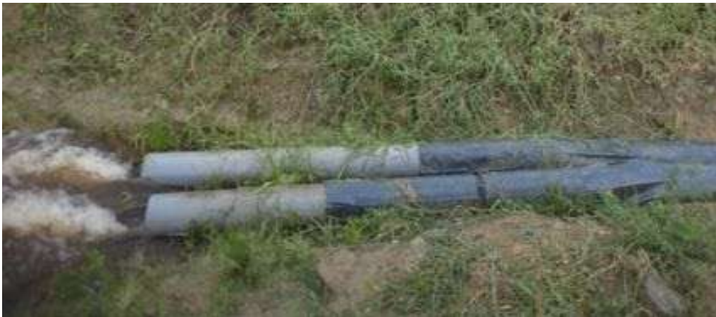
Foto 54. Vista al detalle de la tubería de tubos de PVC y mangas plásticas, que reemplazan al canal.
