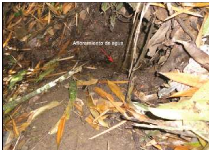
Foto 66. Filtraciones de agua.
