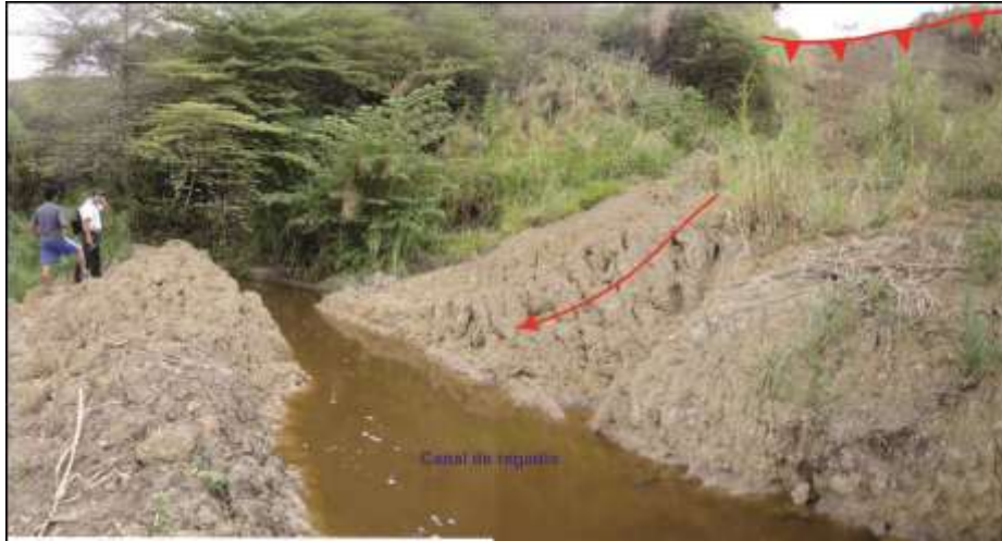
Foto 51. Masa deslizada que ha obturado parte del cauce del canal de regadío.
