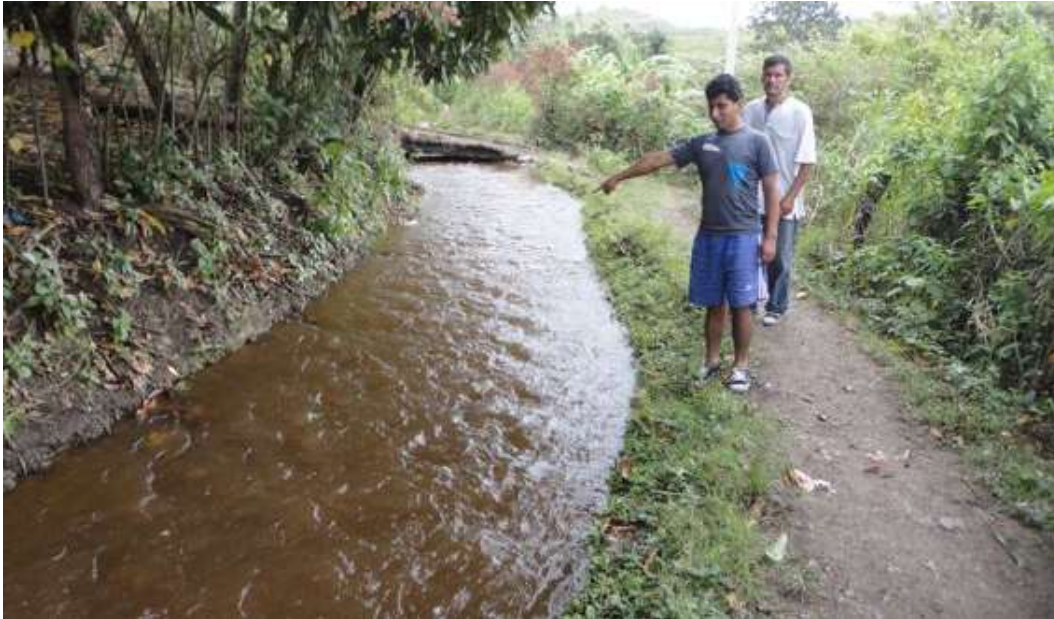
Foto 44. Canal de riego sin revestimiento, lo que permite la infiltración de agua al subsuelo.
