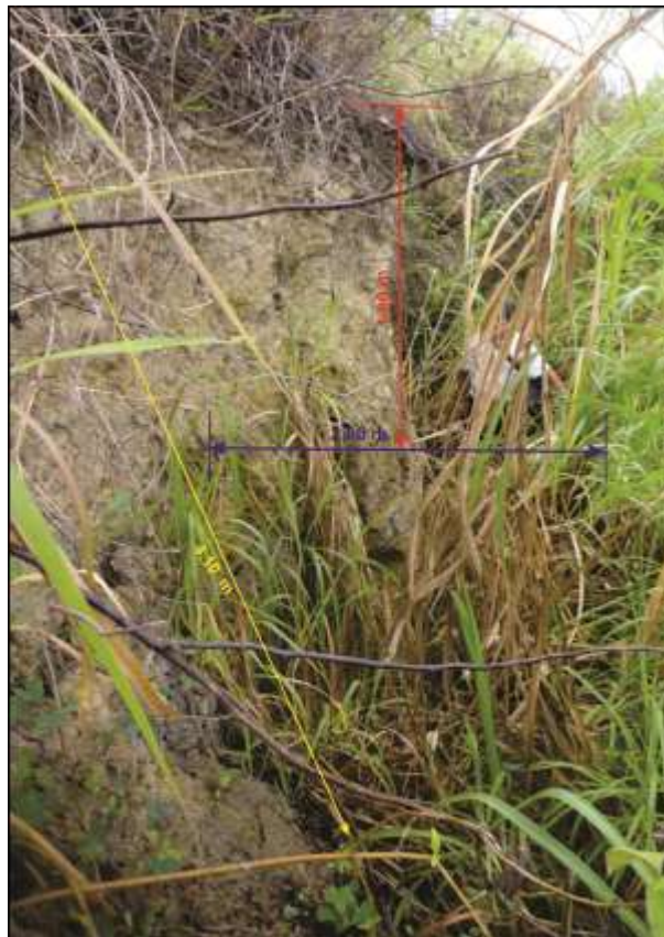
Foto 52. Escarpa antigua, se muestran los desplazamientos verticales y horizontales.
