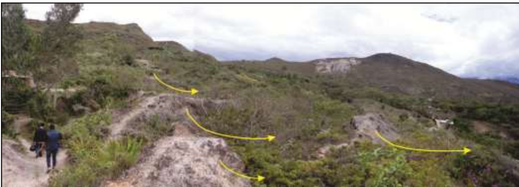
Foto 40. Se muestran los desplazamientos de la masa deslizada, del deslizamiento 2.
