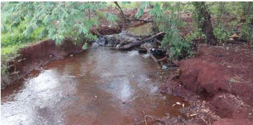
Foto 20. Canal de regadío, sin revestimiento.
