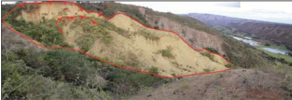
Foto 18. Deslizamiento 1, sector Cunía. En la parte inferior se observa el valle Cunía.
