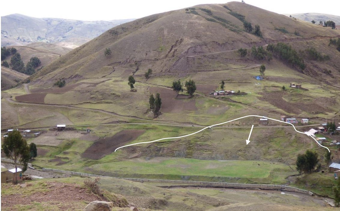
Figura 17. Deslizamiento, sector suroeste de Chuclaccasa, ladera norte del campo deportivo.
