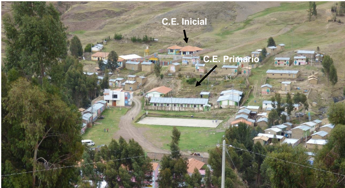
Figura 18. Ubicación de los deslizamientos (flechas de color negro) que afectan las instalaciones de la I.E.P. N°36304 y I.E.I. N°598.
