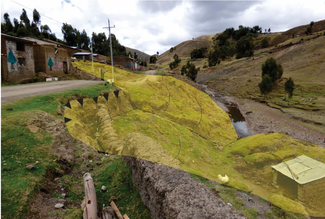
Figura 14. Se observa el deslizamiento del sector sureste de Chuclaccasa, afectó viviendas, al tramo de carretera afirmada Chuclaccasa – Tiquerccasa, y postes de energía eléctrica.
