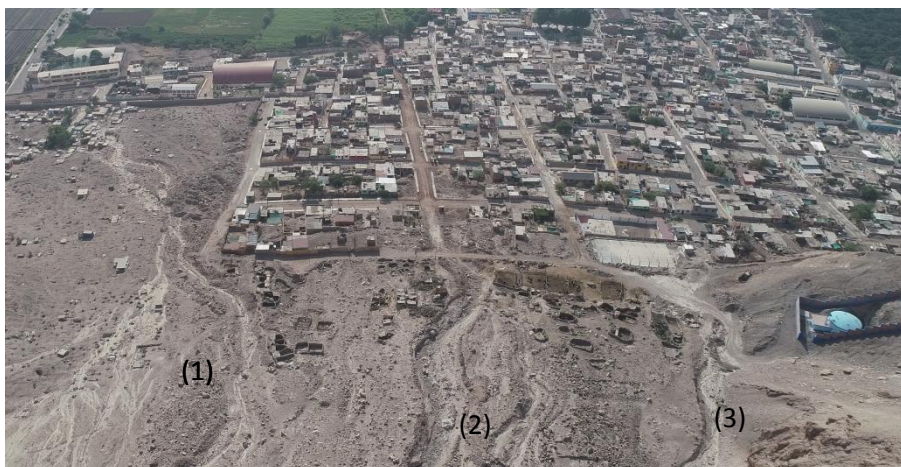
Figura 13. Imagen tomada con dron, donde se muestra los tres ramales de la quebrada que discurrieron hacia Aplao, aprovechando la pendiente; el cauce central que registró la mayor dinámica del flujo, afectando las viviendas de Aplao.
