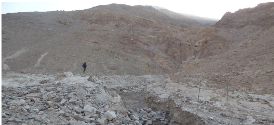
Figura 21. Bloques de roca dejados por los diferentes eventos, se aprecia además la altura del depósito de huaico. En la superficie se aprecia material de color blanquecino, que corresponde a una capa de cenizas volcánicas. También se observa el socavamiento del cauce de la quebrada.
