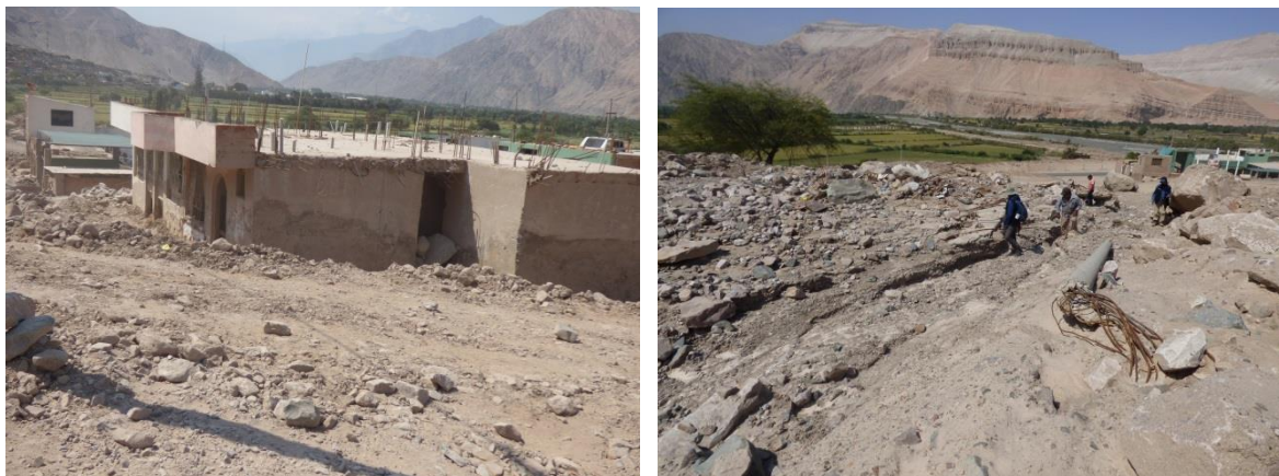
Figura 46. Izquierda se aprecia una vivienda afectada y parcialmente enterrada por el flujo. Derecha, sector que destruyó viviendas, se aprecian los vestigios de postes de tendido eléctrico y lozas de viviendas.
