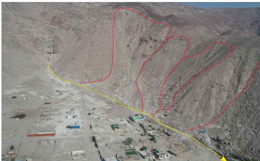
Figura 41. La línea amarilla muestra el trayecto que adquirió el flujo de detritos ocasionado recientemente. Con líneas rojas se demarca antiguos movimientos en masa, ubicados en la margen izquierda de la quebrada.
