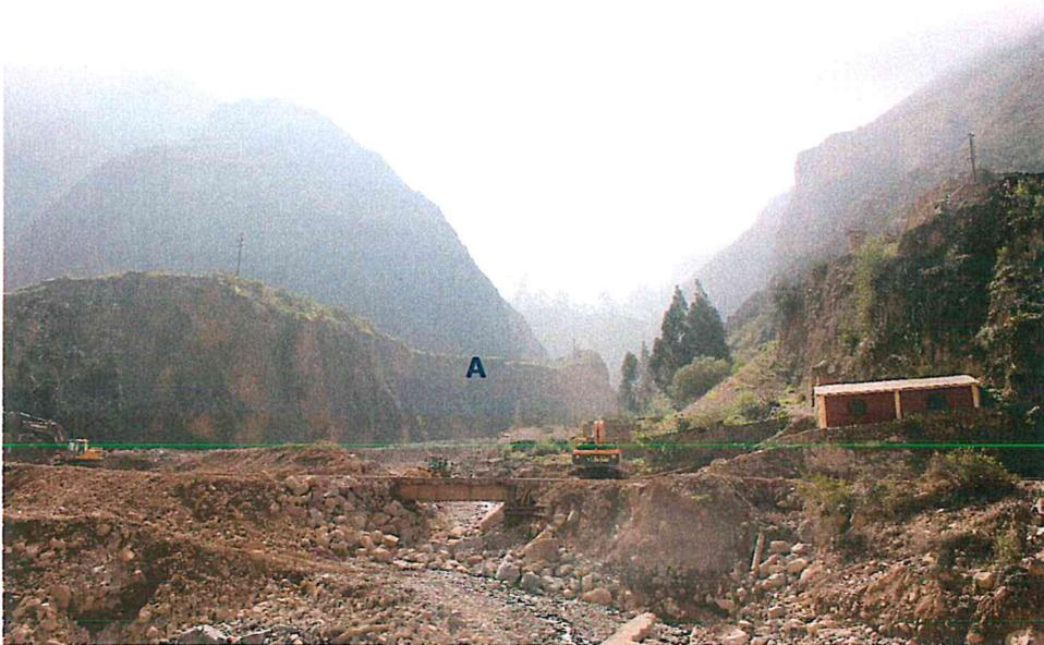
Foto 5.3: En la foto se puede observar los materiales acarreados por el huaico del año 2016 en la quebrada Mayo, así como el socavamiento del depósito proluvial de los años 1998 y 2003 que abrió un nuevo curso para la quebrada Mayo (A) (Foto: L. Fidel, 2016).
