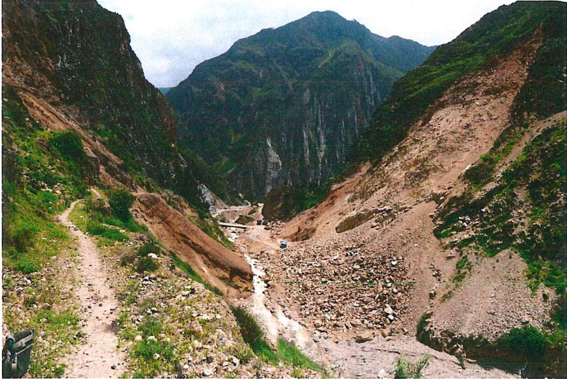
Foto 5.7: Vista aguas abajo en la quebrada Mayo donde se puede ver parte del material de derrumbe que desvió y represo la quebrada; actualmente el caudal de agua discurre pegado hacia la margen derecha produciendo erosión en la base de un depósito de desmonte de mina.
