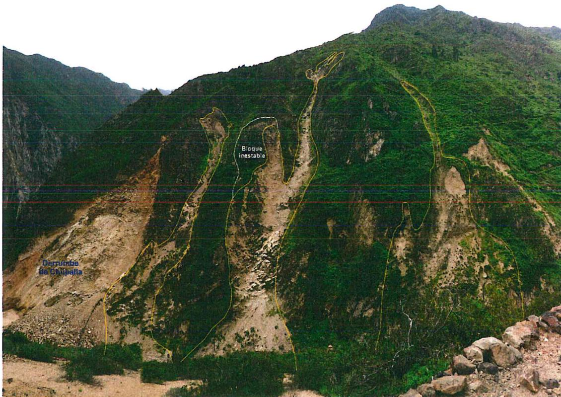
Foto 6.1: Vista de la margen derecha de la quebrada Mayo, donde se puede observar muy cerca del derrumbe de Chupalla, otros derrumbes de menor dimensión que contienen bloques colgados inestables que podrían caer a la quebrada y represarla.
