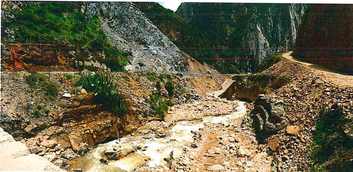
Foto 6.7: Vista aguas abajo desde el puente Viso en donde es posible observar el estado deteriorado en el que se encuentran los dos gaviones de encauzamiento de la quebrada ubicados en ambas márgenes. Hacia el fondo es posible observar también el antiguo puente vehicular caído que obstruye el cauce.
