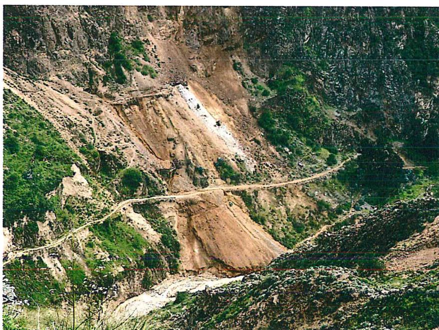
Foto 6.9: Vista en dirección hacia el oeste en la que se puede observar el curso de la quebrada Mayo pegado a su margen izquierda y erosiona la base del depósito de un desmonte de mina acumulado en la ladera.
