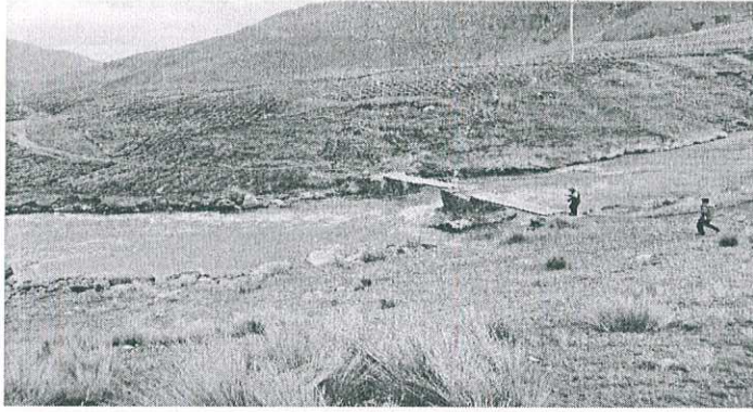
Foto N° 06: Río Aymaña, desborde del Río en épocas lluvias intensas afectando infraestructura vial.
