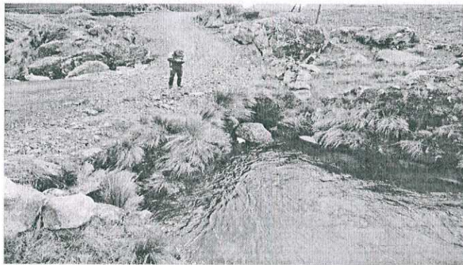
Foto N° 05: Río Acanchara, desborde del Río en épocas lluvias intensas afectando infraestructura vial.
