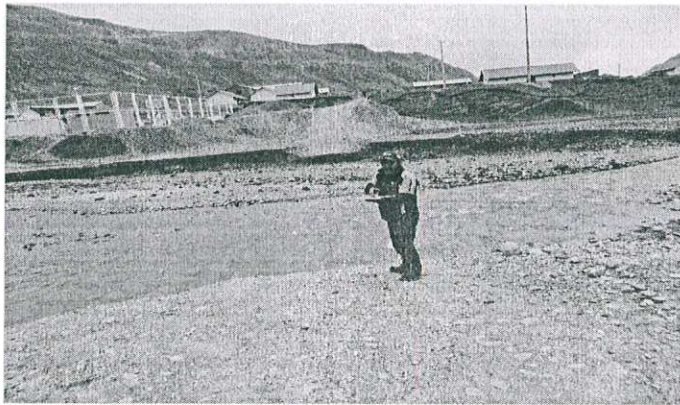
Foto N° 07: Río Minaspata, desborde del Río en épocas lluvias intensas afectando a los pobladores.
