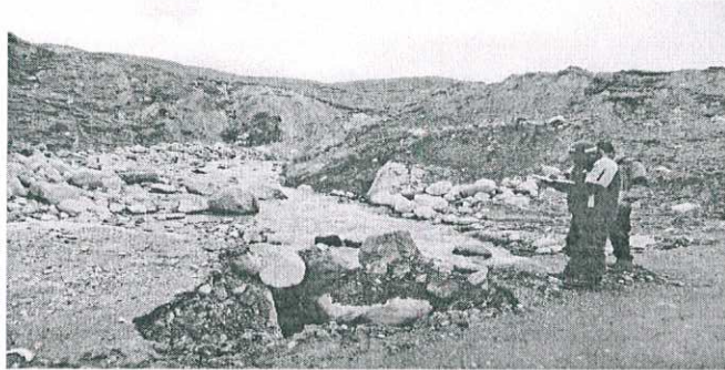
Foto N° 04: Río Antamayo, desborde del Río en épocas lluvias intensas afectando infraestructura vial.
