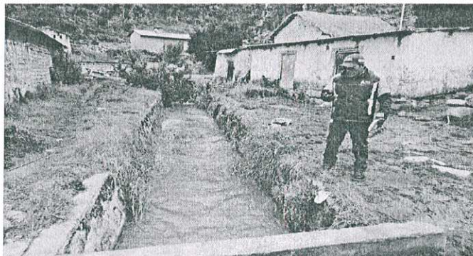
Foto N° 01: Quebrada Quellomayo, desborde de quebrada en épocas de nevada y lluvias intensas.
