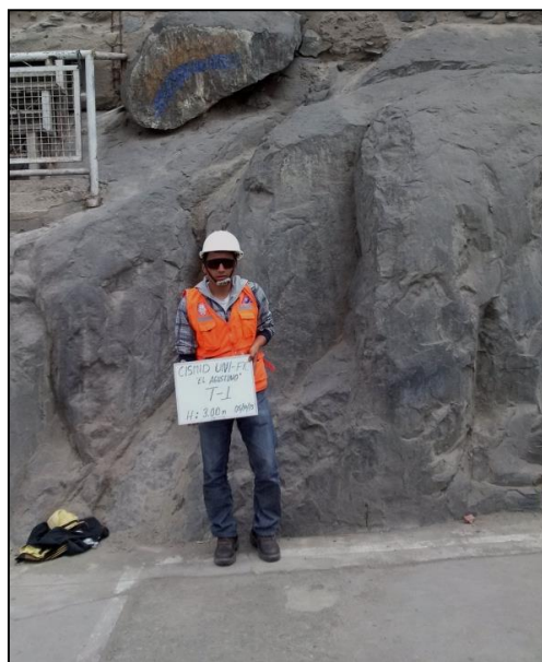
Figura 7.2. Talud de roca en el distrito de El Agustino
