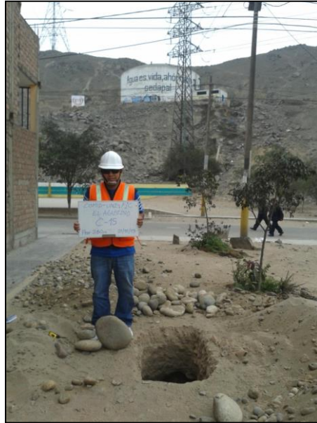
Figura 7.1. Excavación de calicatas en el distrito de El Agustino
