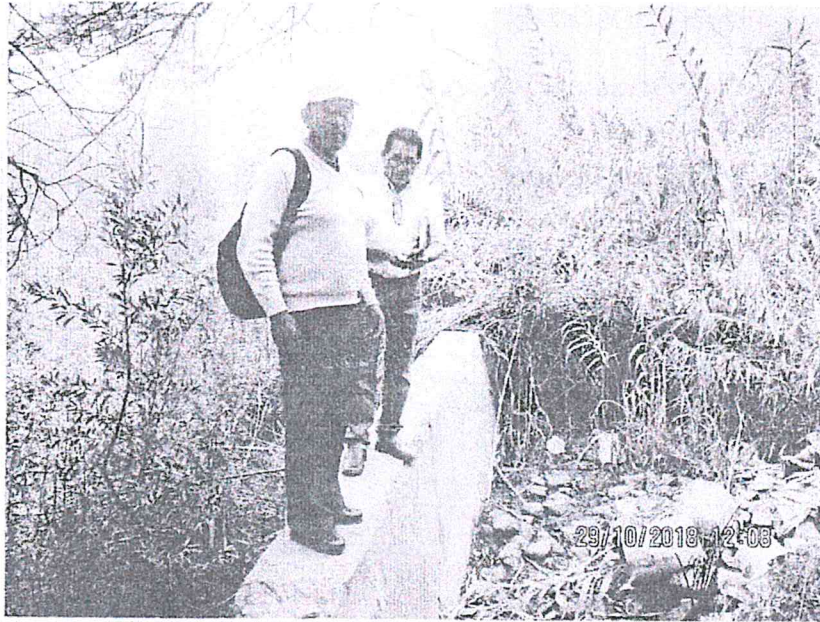
FOTOGRAFIA N° 01: Parte del Muro de Contención- Río Jequetepeque.
