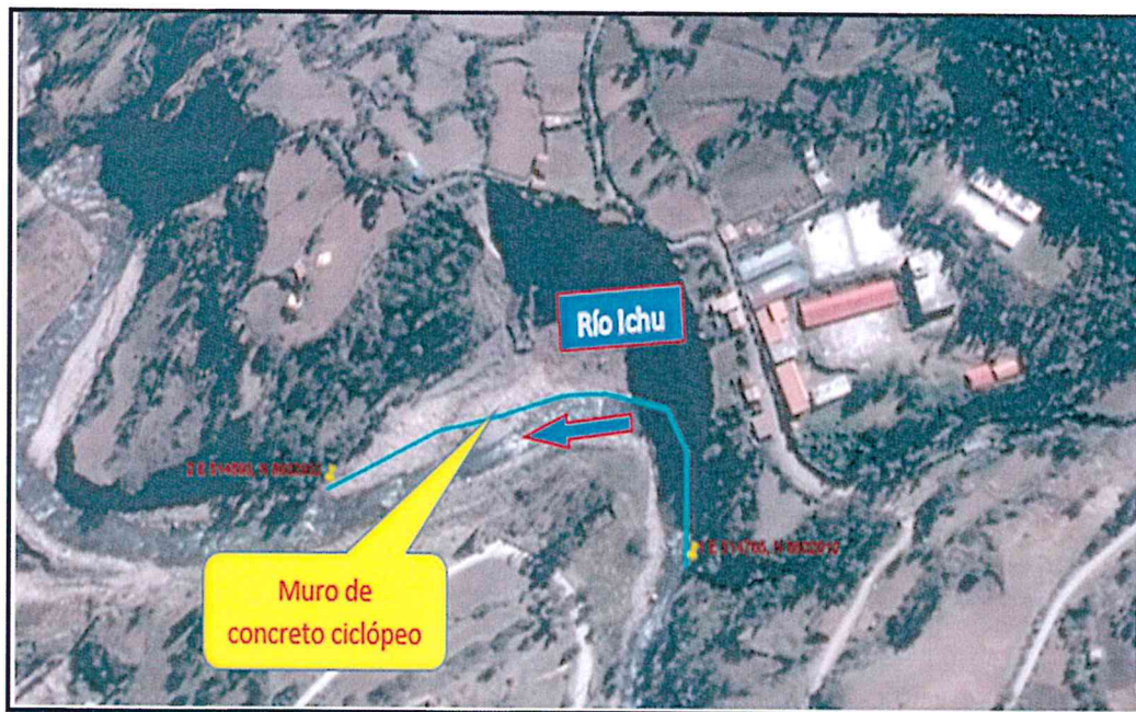
Imagen satelital del tramo identificado como punto crítico
