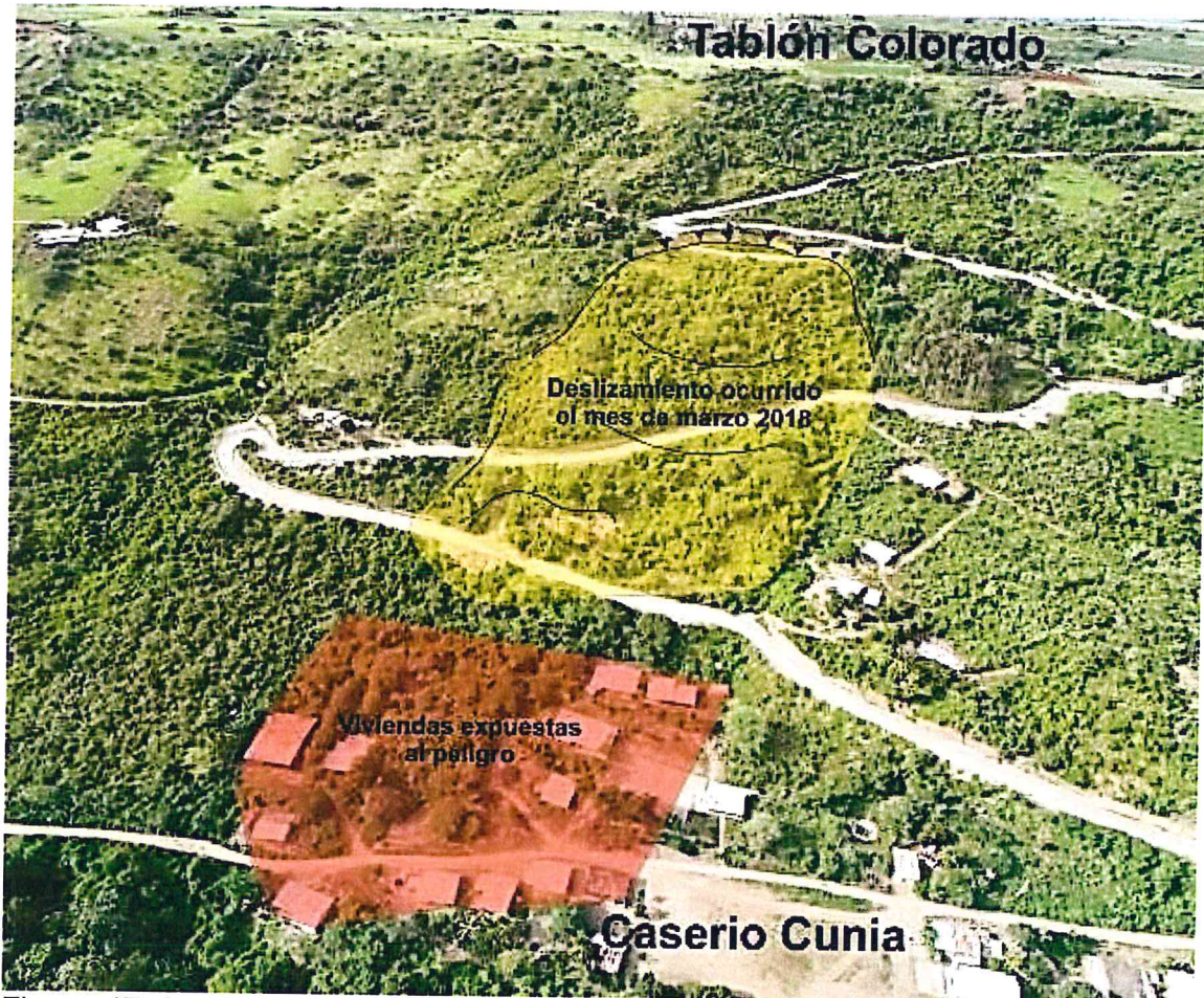
Figura 17. Imagen tomada con Drone del caserío de Cunia, se observa viviendas expuestas al peligro por movimientos en masa de tipo: deslizamiento, ocurrido en marzo 2018.
