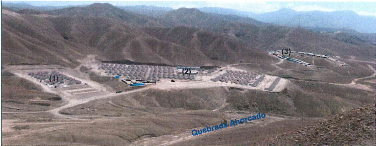
Figura 27. Se aprecia la zona de albergue temporal, asentados en la cima de las colinas, en el sector (2), se parecía el relleno.
