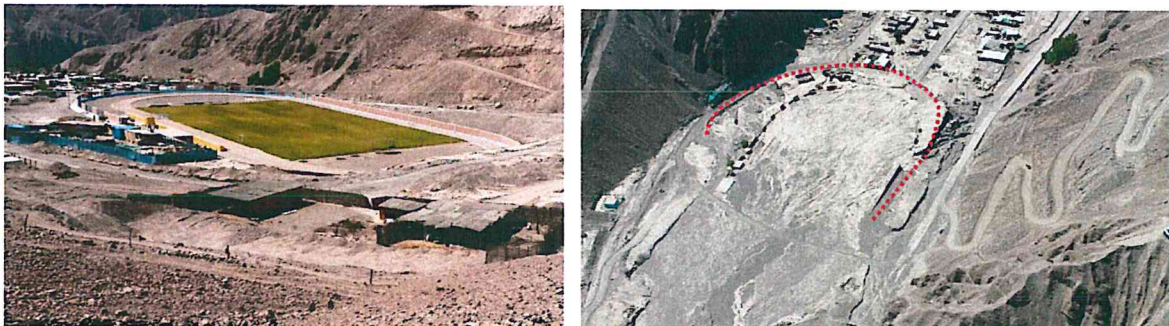
Figura 8. En la vista de la izquierda se aprecia el estadio después del evento del 2015. Vista de la derecha, se aprecia el estadio cubierto por el huaico del 2019; se marca en líneas rojas los límites del estadio.
