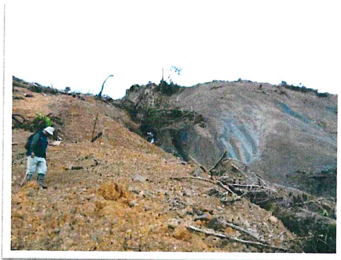
Foto N° 7: Flujo de detritos en el sector medio del canal de la quebrada Talanquiato, generado como producto del deslizamiento en la parte superior. Nótese el arrastre de árboles que se desbordaron del cauce de la quebrada).
