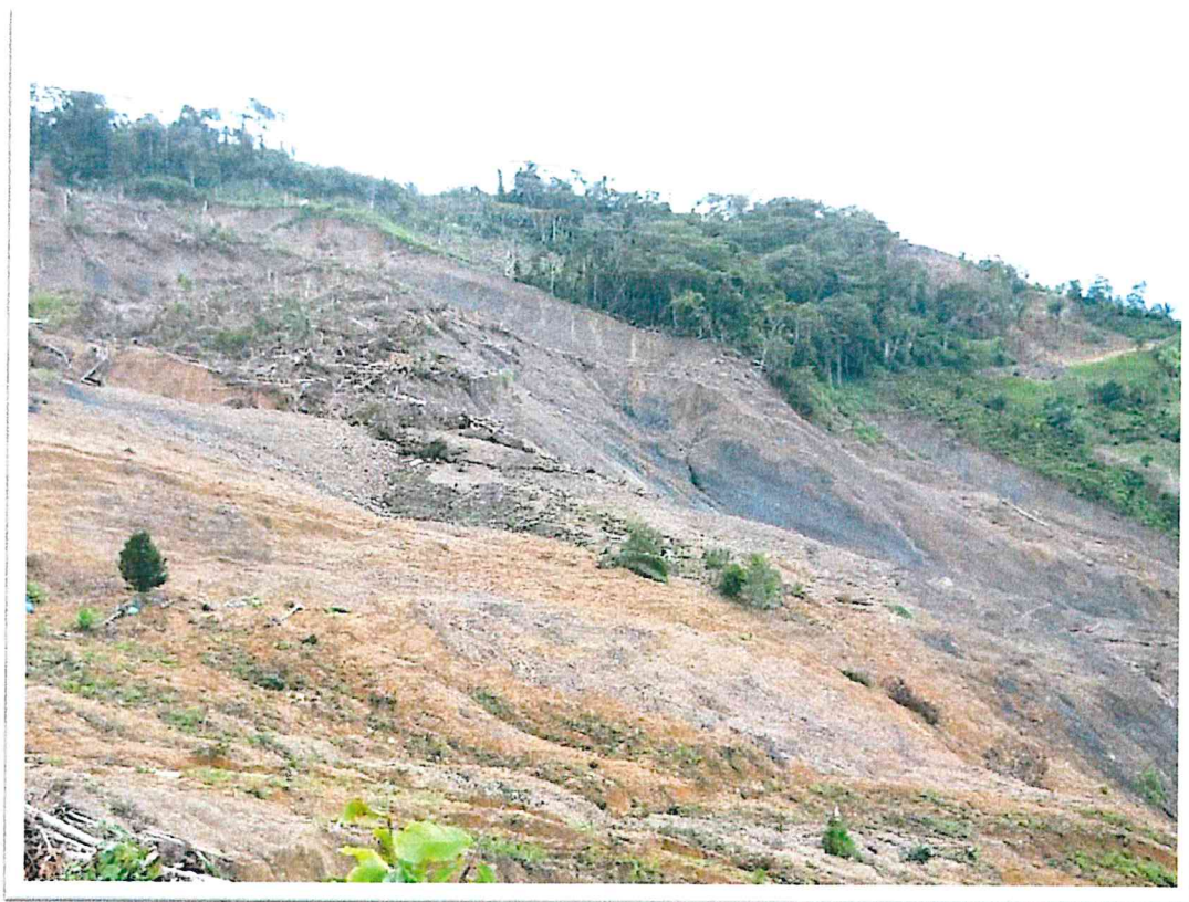
Foto N° 3: Substrato rocoso de la zona, compuesto por limoarcillitas pizarrosas negras, intercaladas con areniscas cuarzosas, en estratos de 10 cm a 20 cm de espesor, muy fracturadas y con intensa meteorización; zona donde se generó el deslizamiento de Talanquiato. Al pie el depósito de movimiento en masa antiguo.
