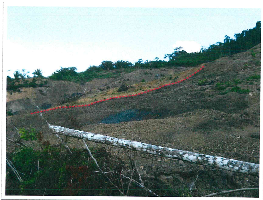
Foto N° 5: Vista lateral del deslizamiento rotacional en la parte superior de la quebrada Talanquiato, con escarpe de forma semicircular.
