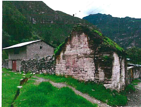
Viviendas en estado muy mala, las vías no cuentan con sistemas de drenaje lo que permite la saturación del suelo y por consiguiente el humedecimiento de las estructuras de adobe.
