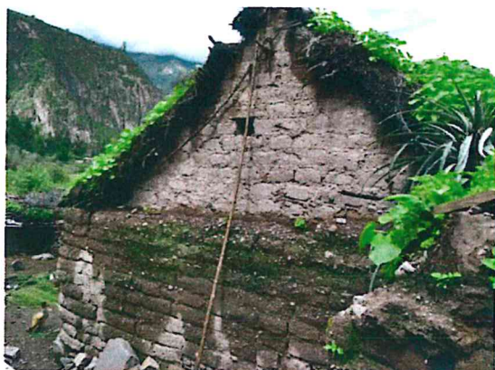
Viviendas de adobe en mal estado, muestran paredes de adobe humedecidas por la lluvia, así como paredes de adobe agrietadas.
