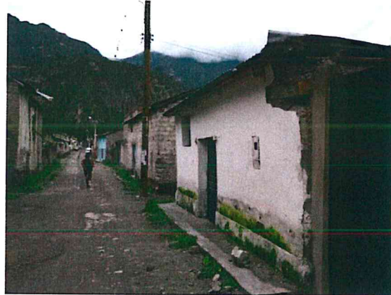
La saturación del suelo produce el humedecimiento de las paredes de adobe de las viviendas.
