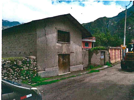
Viviendas de adobe en mal estado, muestran paredes de adobe humedecidas por la lluvia, así como paredes de adobe agrietadas.
