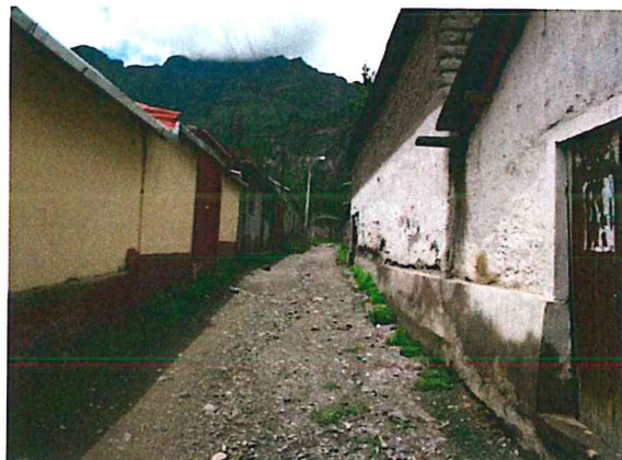
La saturación del suelo produce el humedecimiento de las paredes de adobe de las viviendas.
