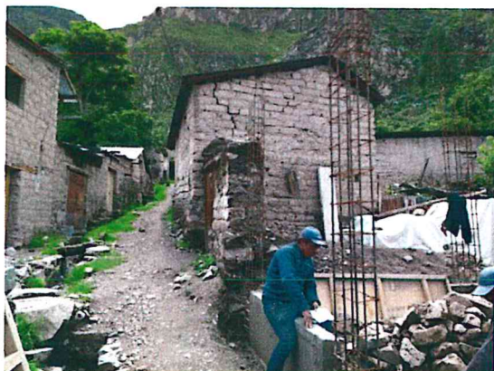
Viviendas en estado muy mala, las vías no cuentan con sistemas de drenaje lo que permite la saturación del suelo y por consiguiente el humedecimiento de las estructuras de adobe.
