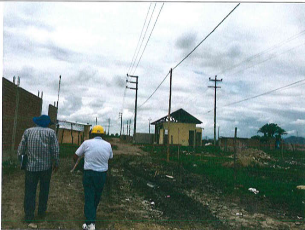
Calles del centro poblado de Zaña, con presencia de barro como consecuencia de inundación.
