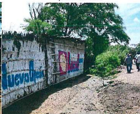
FOTO 02. Vivienda con pared de quincha con barro
