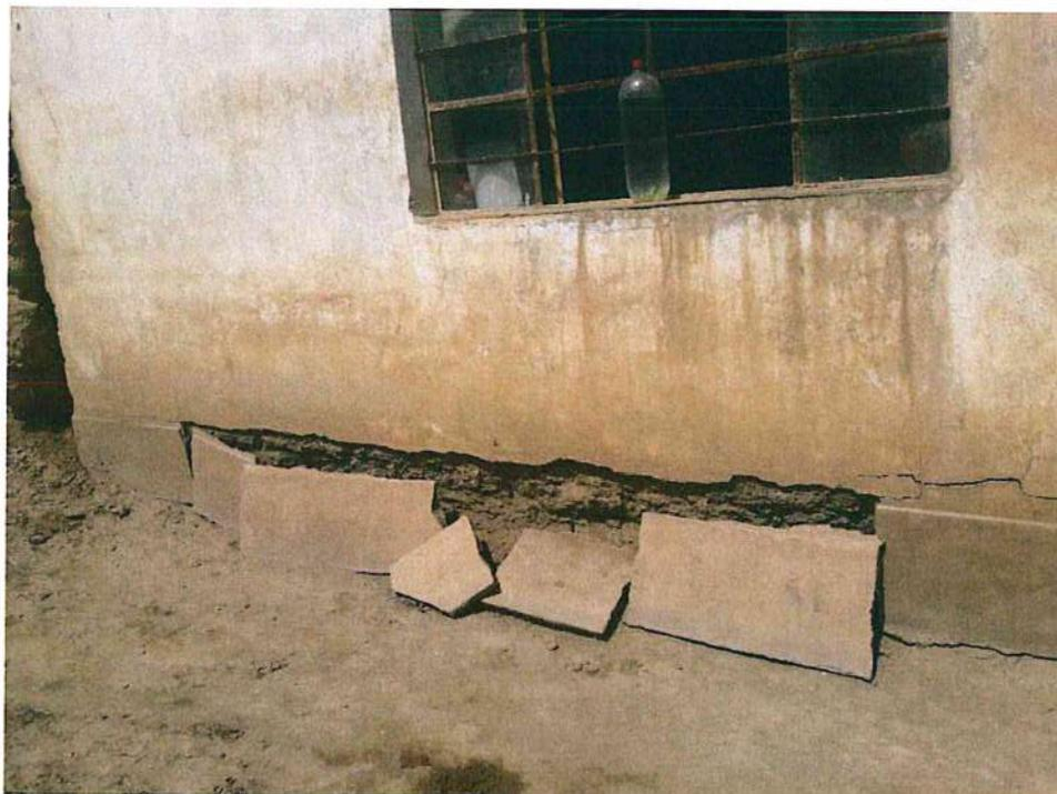
Vivienda con muros de adobe con sobre cimientos en proceso de colapso, como consecuencia de inundación por lluvias intensas.
