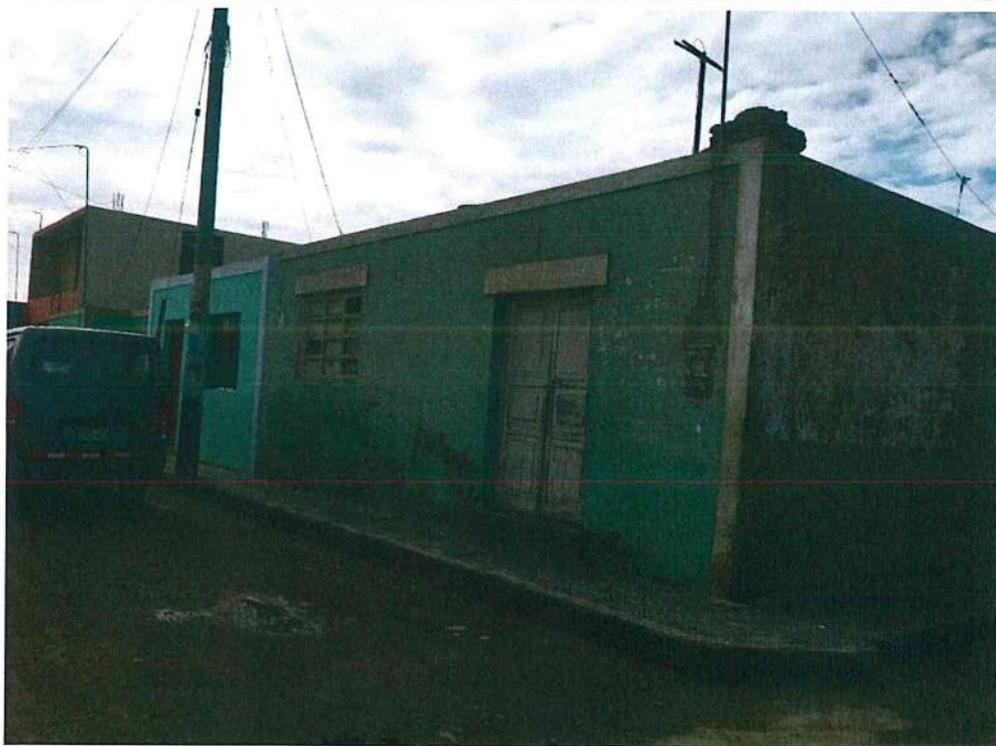
Vivienda con muros de adobe y torta de barro con severo daño estructural.
