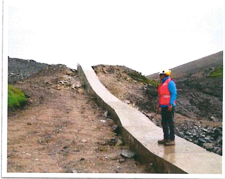
Foto N° 4: Tubería levantada (anulada) y revestida en forma externa con Cemento, luego del incidente ambiental; ancho promedio: 0.80 m.
