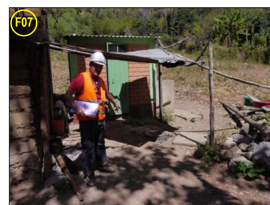
F07.- Elemento Expuesto - Modulo de S.H. Sistema de desagüe por arrastre hidraulico. Se observa el pozo septico y caja de lodos.
