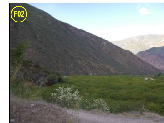
F02.- Elemento Expuesto - Trocha Carrozable. Ancho de calzada aproximadamente 3.50m
