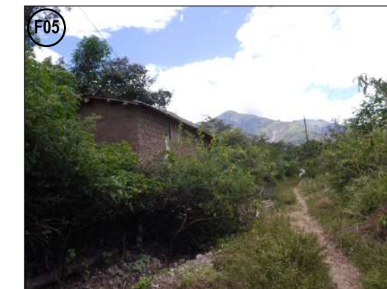
F05.- Elemento Expuesto - Trocha carrozable. Ancho de calzada aproximadamente 3.0m. Superficie de rodadura deteriorada
