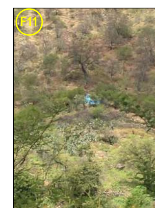
F11.- Elemento Expuesto Reservorio de agua de Concreto Armado
