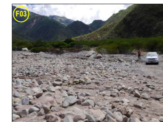
F03.- Elemento Expuesto - Trocha carrozable en zona de llanura de inundación. Ancho aproximadamente 3.50m
