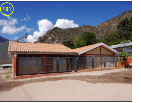
F01.- Elemento Expuesto - I.E.Inicial N°425-105/Mx-U. Edificación mixta de porticos de concreto armado y albañilería confinada.
