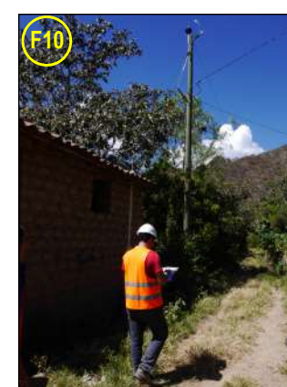
F10.- Elemento Expuesto Linea electrica de Distribución. Linea Monofasica
