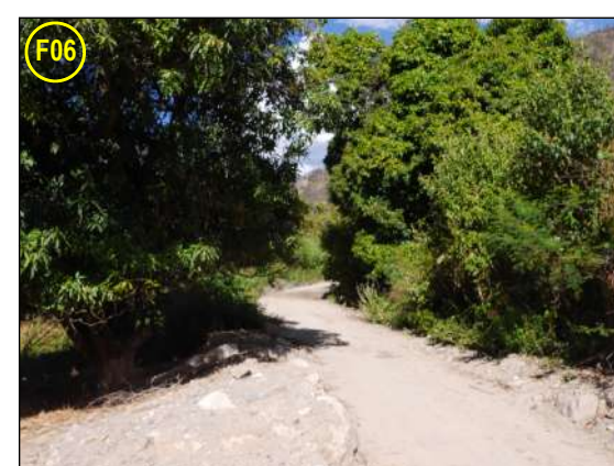
F06.- Elemento Expuesto - Trocha carrozable. Ancho de calzada aproximada 3.0m. Superficie de rodadura deteriorada.
