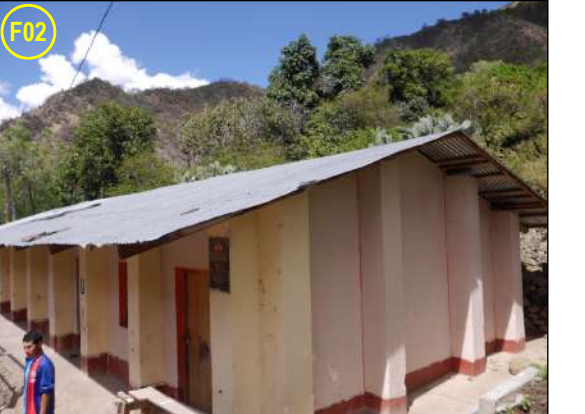
F02.- Elemento Expuesto - I.E.Primaria Paccaypampa. Edificación de muros de adobe reforzado con contrafuertes de adobe.
