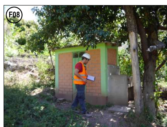
F08.- Elemento Expuesto - Modulo de S.H. y lavadero de concreto. Sistema de desagüe por arrastre hidraulico.
