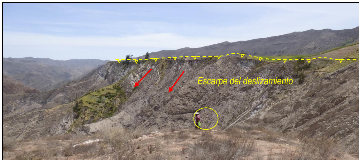
Foto 11. Escarpa del deslizamiento (indicados con flechas de color rojo). Tiene una altura aproximada de 15 m.
