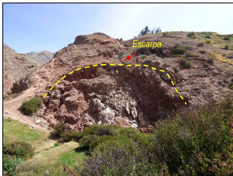
Foto 16. Zona de derrumbe al noreste del pueblo de San Basilio.
