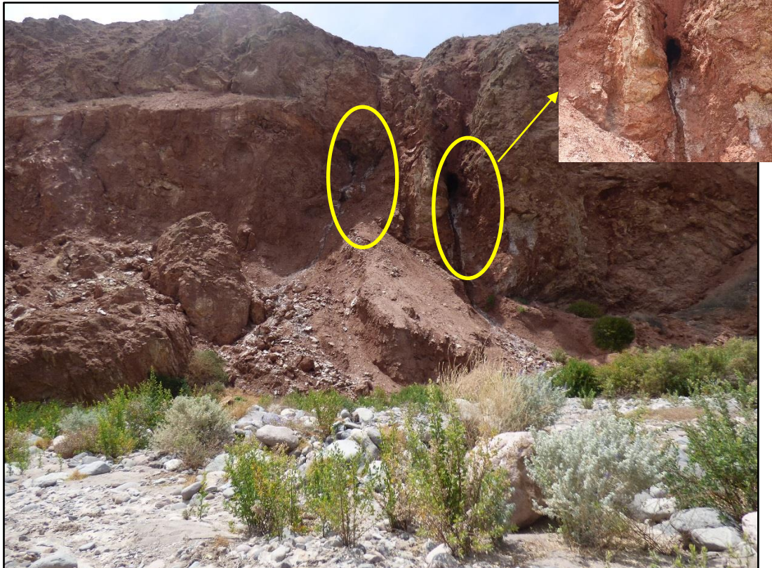
Foto 15. Fracturas en zonas de derrumbes por donde fluye agua.
