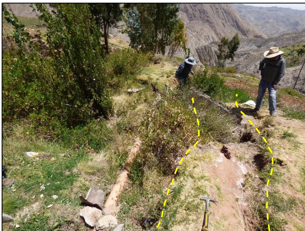
Foto 12. Grietas tensionales, se ubican en la parte alta del escarpe del deslizamiento.
