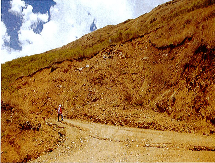
Foto 15: Deslizamiento producido por el corte de talud para la ampliación de la trocha carrozable.
