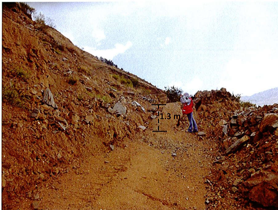
Foto 12: Se observa el desnivel de 1.3m en el segundo desarrollo de la trocha Tomaykichwa – Chinchubamba.
