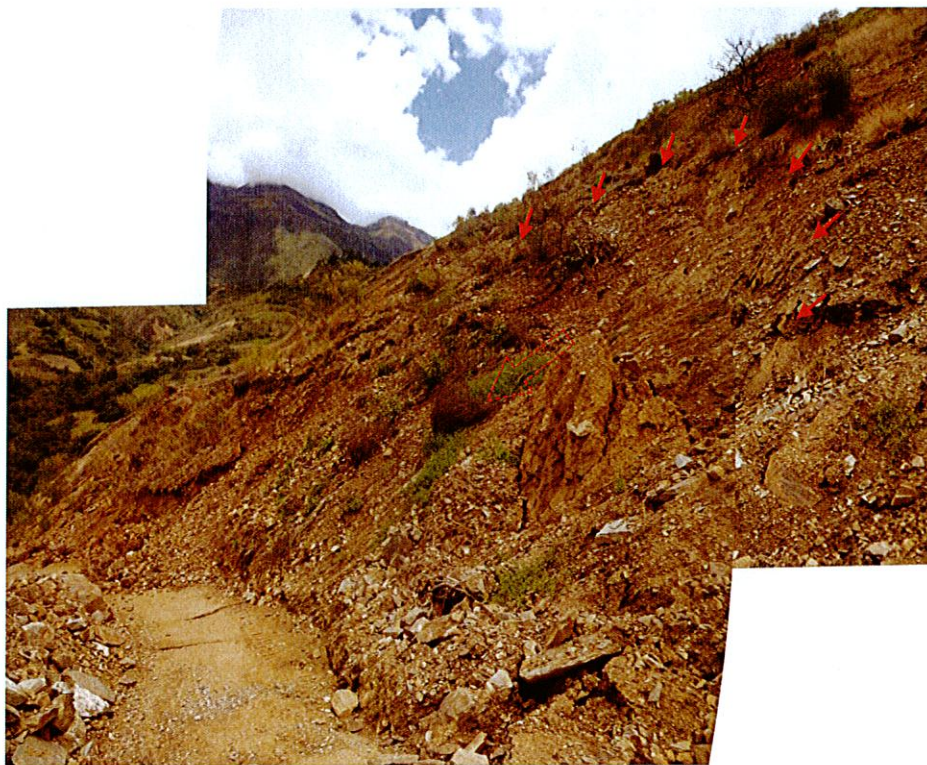
Foto 11: Las flechas rojas demarcan el deslizamiento ocurrido en el segundo desarrollo.
