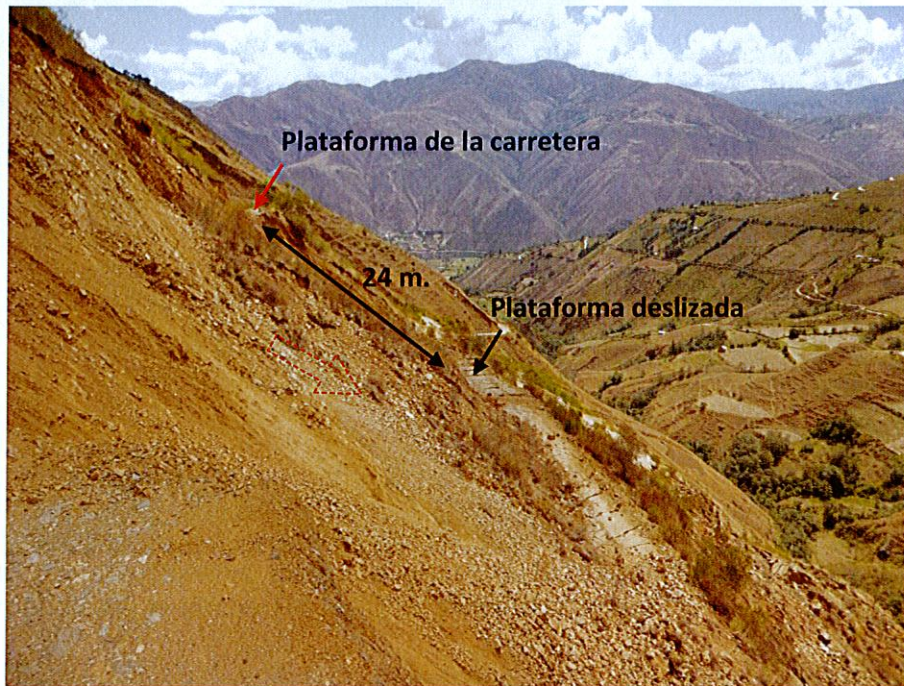
Foto 17: La flecha roja muestra el trazo normal de la carretera Tomaykichwa-Chinchubamba; la flecha negra muestra la plataforma deslizada 24 m. La flecha punteada muestra la dirección de movimiento del deslizamiento.
