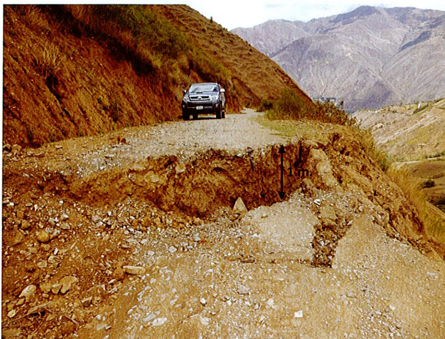
Foto 09: Se observa el escarpe de 1m en el primer desarrollo de la trocha Tomaykichwa – Chinchubamba.
