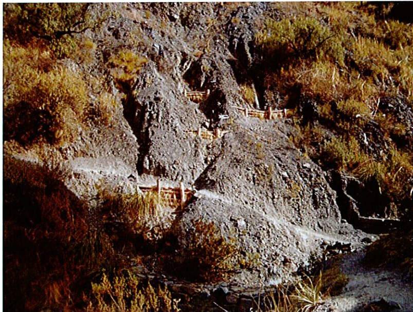
Diques de madera en las cabeceras de cárcavas. Después de ser llenado por sedimentos, se plantara arbustos para estabilizar tanto el talud
