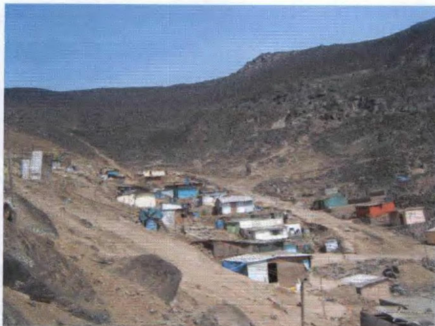
Foto N°2. Obsérvese viviendas en el cauce y otras en la ladera
