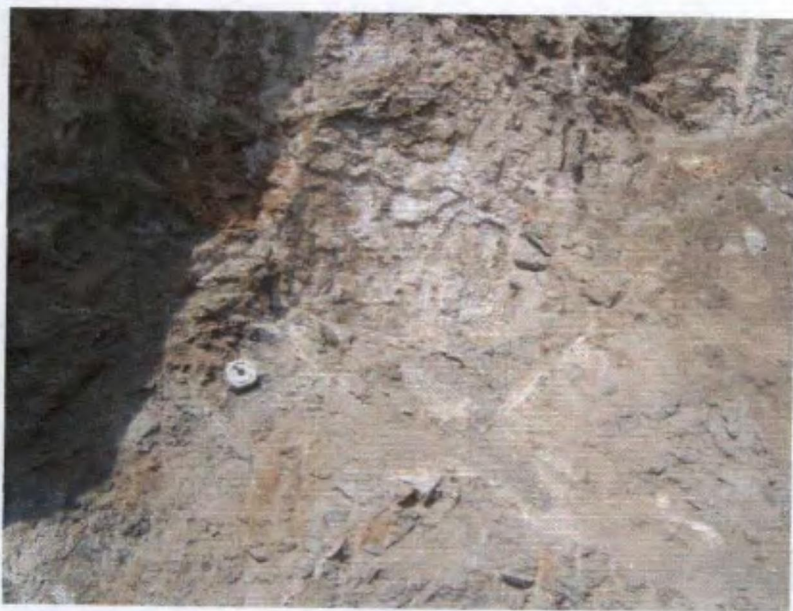
Foto N°3. Rocas intrusivas, presencia de panizo .
