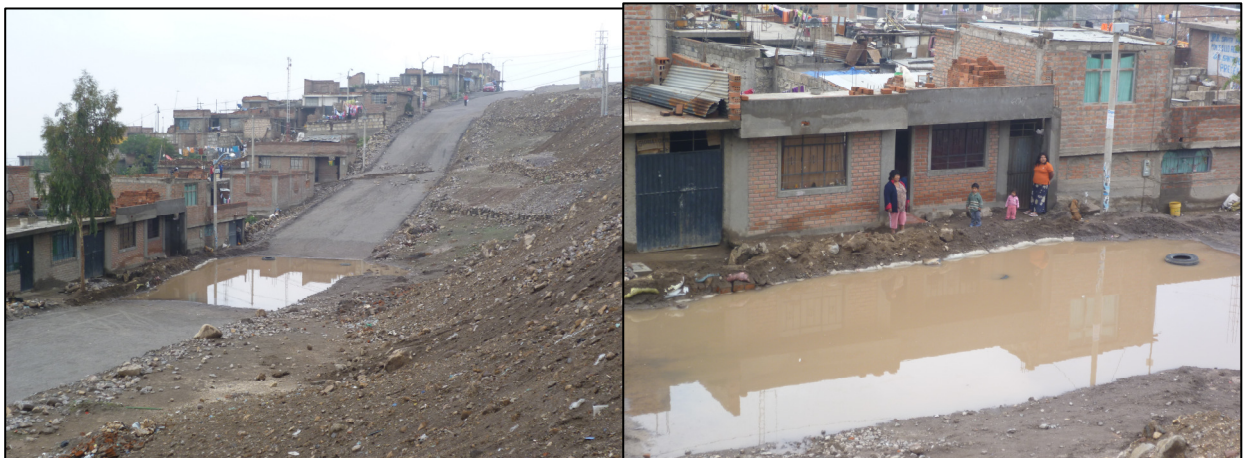
Foto N°21. Estado de casas ubicadas en la "Isla" (Villa Unión) inundadas con aguas de lluvias recientes.
