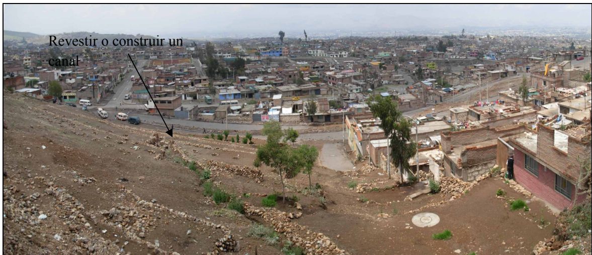
Foto N°25.- En este sector se debe construir un sistema de drenaje, revistiendo el canal existente o diseñando otro canal cerrado o tunel de agua.
