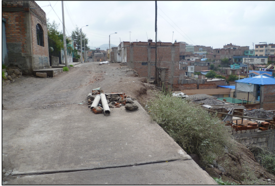
Foto N°13. Vista de la calle Mollendo (tramo 2), la cual en parte está cubierta con losas de cemento. El derrumbe se produce en la zona descubierta
