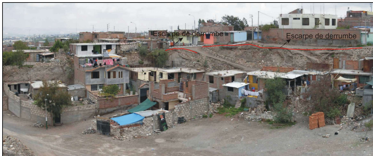
Foto N° 9. Vista de la escarpa de derrumbe en la calle Ricardo Palma (tramo 2), visto desde la Av. Independencia.
