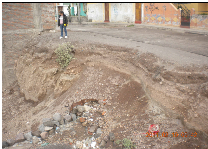
Foto N°16. Vista de la calle Mollendo (Tramo 4)
