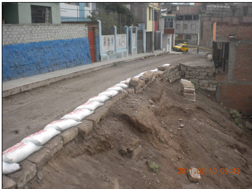
Foto N°17. Vista del tramo 5 de la calle Mollendo.
