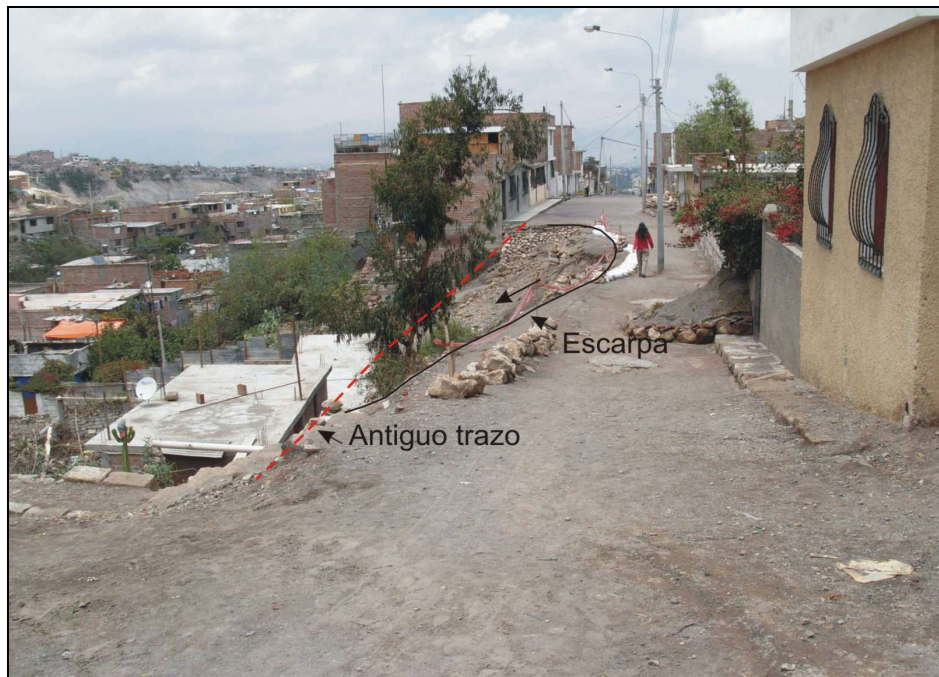
Foto N°4. 4ta cuadra de la calle Ricardo Palma, donde los procesos de erosión y derrumbe han afectado un tramo de 35 m de dicha calle.
