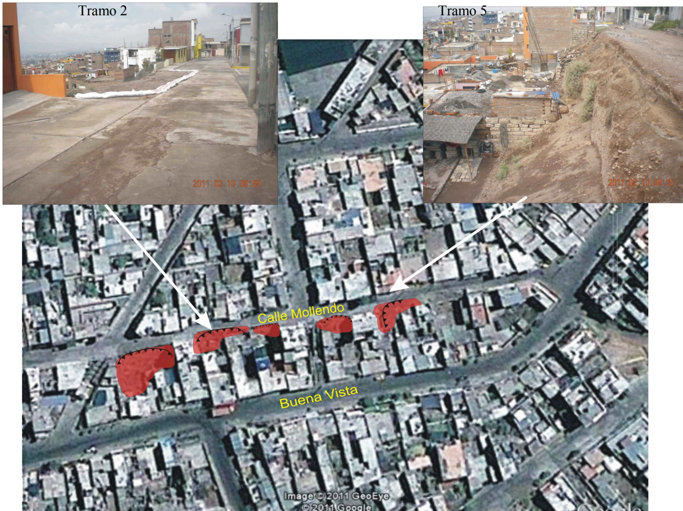
Foto N° 10. Imagen Google de la calle Mollendo, entre 2da y 3ra cuadra, donde los procesos de erosión y derrumbe vienen afectando dicha calle y viviendas. Además se presentan dos vistas de las áreas estudiadas.
