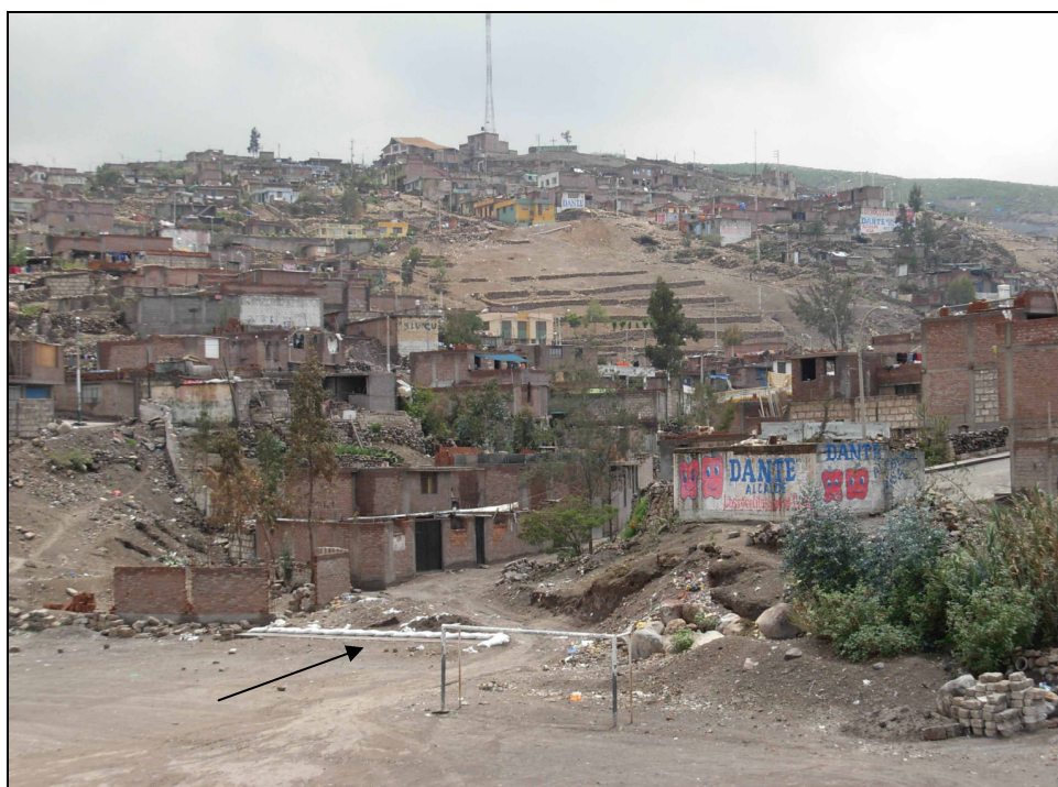
Foto N°23. Vista del sector tripartito (sector 3). La flecha señala el inicio del canal de agua, hasta donde desembocan las aguas producto de lluvias
