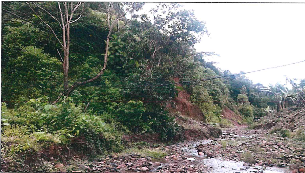
Fotografía 22. vista del deslizamiento, ubicado a la margen derecha de la quebrada Paucar.
