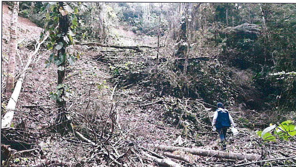
Fotografía 12. Vista de árboles caídos en el cuerpo del deslizamiento.
