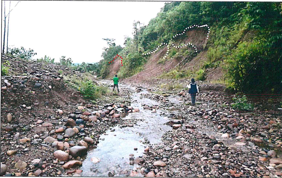
Fotografía 21. Vista de un deslizamientos con tres niveles de escarpe, ubicado hacia la margen derecha de la quebrada Paucar.
