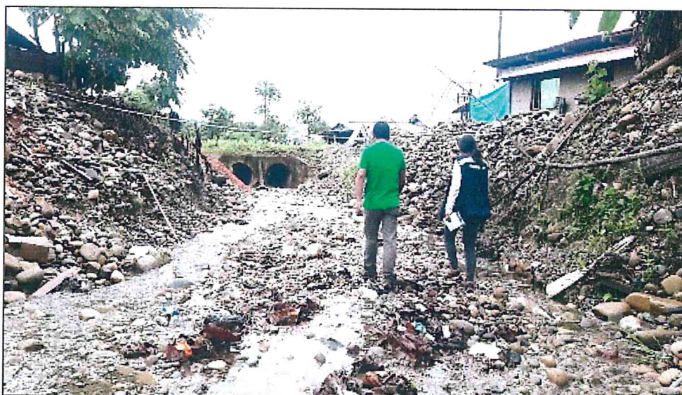
Fotografía 19. Vista de la desembocadura del flujo de detritos, a la altura de la av. Inambari.
