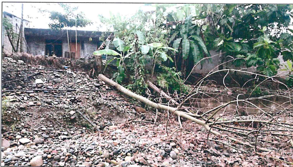
Fotografía 17. Vista de viviendas ubicadas a 5 m del cauce de la quebrada Paucar.
