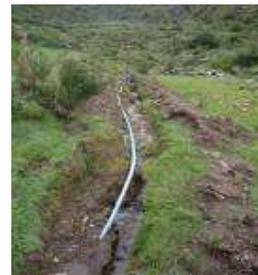
En estas fotos se puede ver el estado de parte del sistema de agua potable que alimenta a la CC de Siusa, en el Sector de Chejtaccacca, en las dos primeras el Colapso de una de las bocatomas que alimenta este sistema producto de la reptacion de suelos y en la s tercera el agua que se conduce por el suelo mas no asi por la tubería destinada para este fin.
