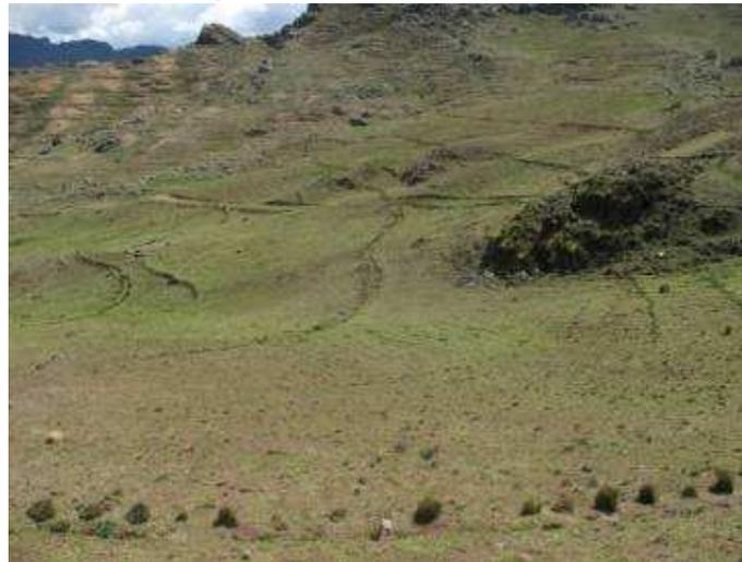
Imagen mostrando las zanjas de infiltración, proyecto realizado por CEDEP AYLLU y la CC de Siusa, estas zanjas se proyectan siguiendo la misma cota alrededor de toda la cabecera de cuenca y tienen la función de capturar las aguas de lluvias e infiltrarlas para la recarga de acuíferos.
