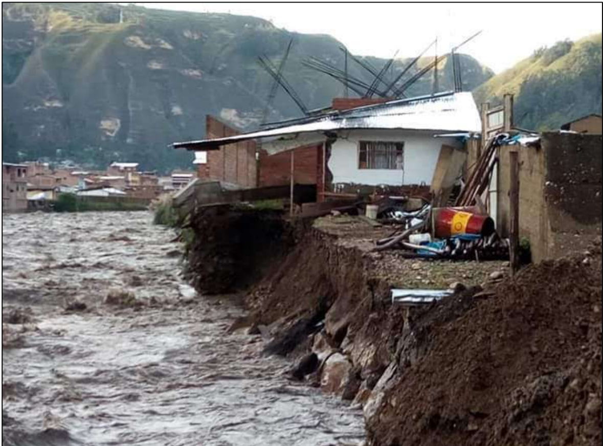
Figura 42: Fotografía de las inundaciones y arrastre de las viviendas
