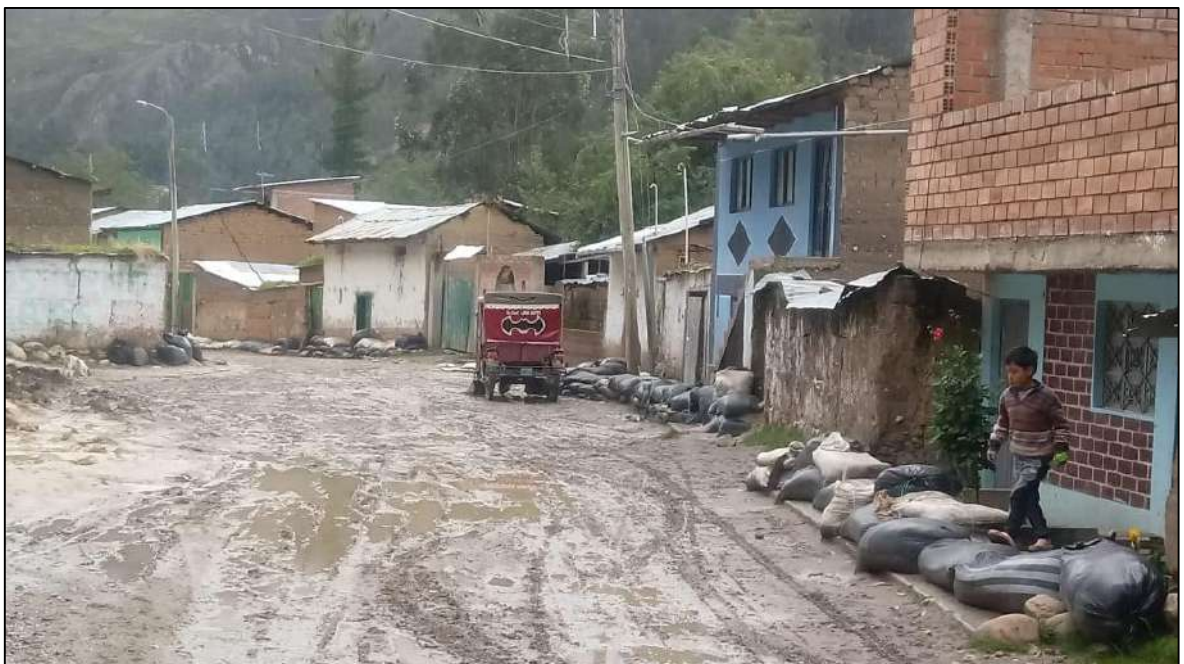
Figura 03: Viviendas de adobe y viviendas de material noble con techos de calamina
