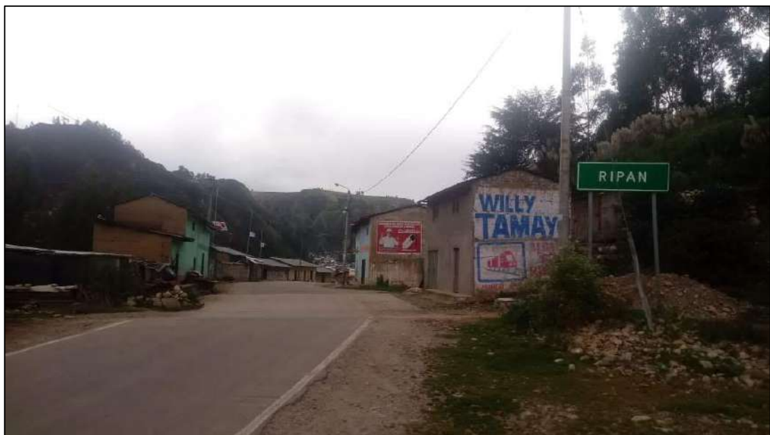
Figura 05: Viviendas construidas con adobe con techos de calaminas
