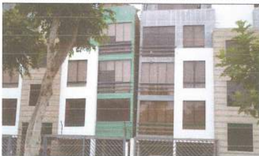
Fotografía N° 04: Hundimiento de edificios en el sector Limatambo.
