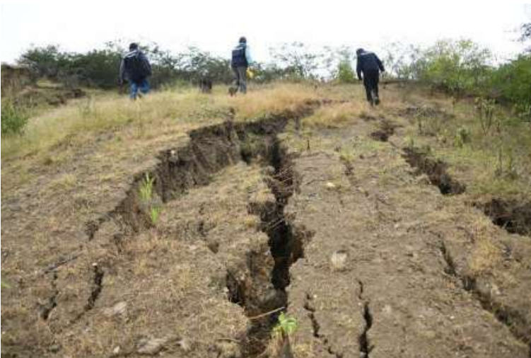
Foto 3: Agrietamientos del terreno recientes, pertenecen al sector derecho al deslizamiento antiguo.
