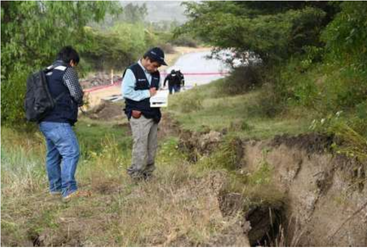
Foto 4: Escarpe lateral de la zona reactivada, con separaciones hasta de 1 m.
