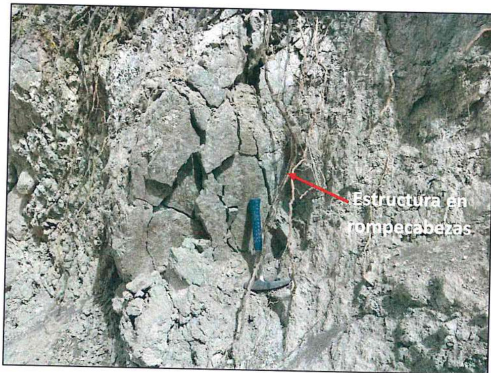
Figura 15: Roca de 1.5 m de diámetro que presenta fracturamiento con estructura en rompecabezas.
