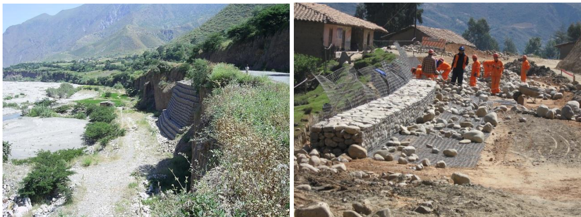
Foto 12. Ejemplos de construcción de muro de gaviones para protección de talud inferior de carretera.
