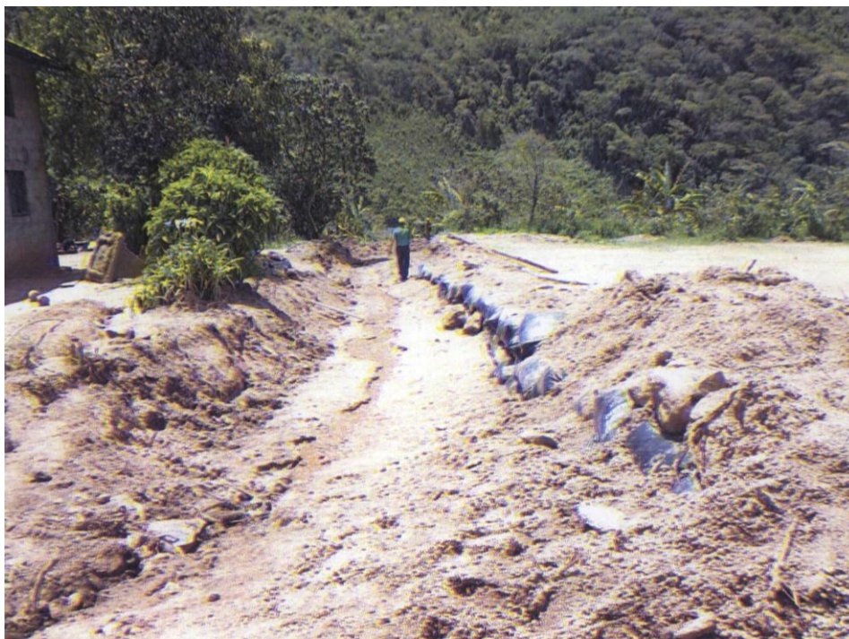
Foto 5. Parte del flujo de detritos que afectó algunas viviendas de la comunidad San José de Villano, para mitigar un poco el efecto del huaico se colocaron sacos terreros. (Foto M. D. Masma).
