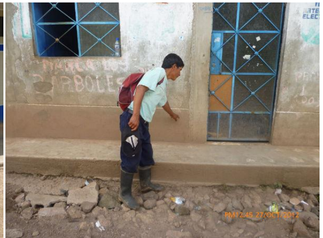
Foto 9. Vista de las marcas en las paredes que indican la altura aproximada que alcanzó el huaico (0,5 m). Foto M.D. Masma.
