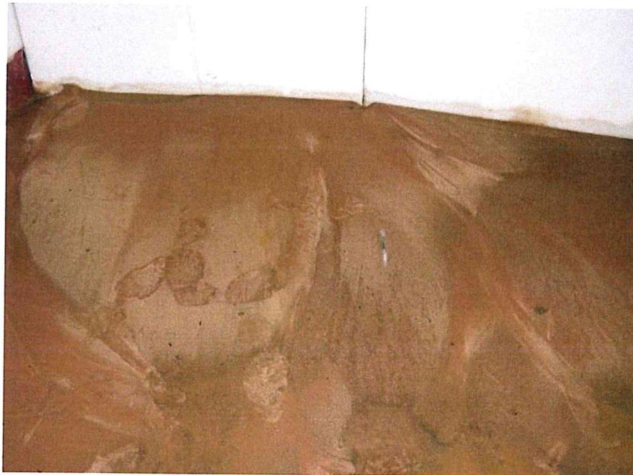
Fotografía 1. Volcán de arena de hasta 1.0m de radio dentro de una vivienda en el sector 2 de Mayo.
