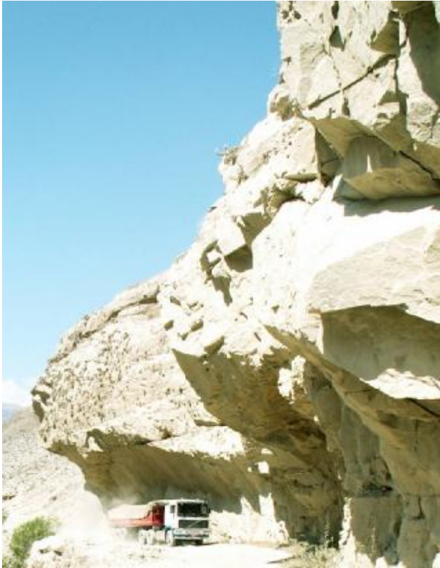
Foto 1. Caida de rocas. Carretera Sayán-Churín
