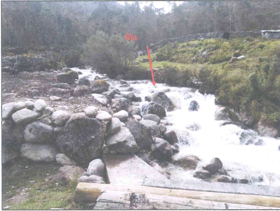
Figura 24: El río Chanchos que fluye en dirección SE a NO, en cuya margen izquierda se encuentra la localidad de Chupaca
