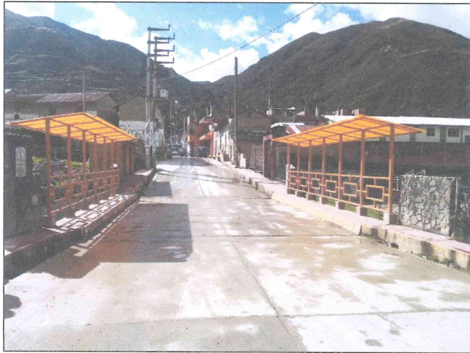
Figura 04: Viviendas construidas de materia noble y material noble con techos de calaminas
